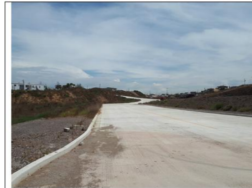
Pavimento a base de concreto asfáltico en muy buen estado, calle Camino Vecinal
