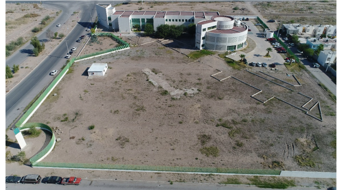
Panorámica aérea del predio en donde se llevará a cabo la construcción de Unidad de Medicina Familiar 10 consultorios con Atención Médica Continua en el Municipio de Torreón, Coahuila.
