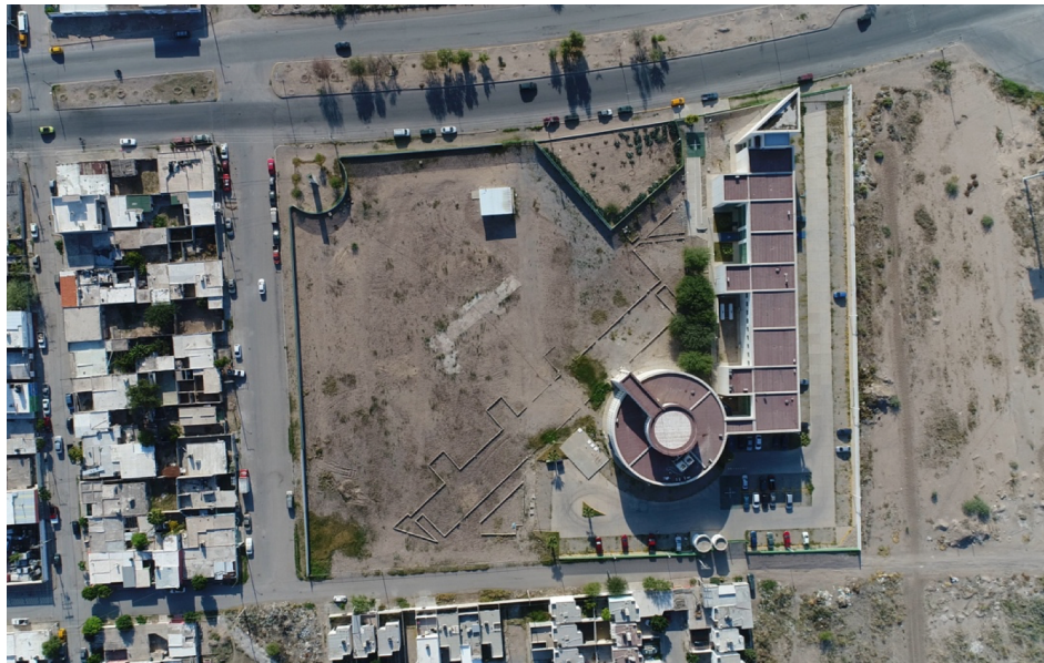
Aspecto general del predio del proyecto donde claramente se puede observar desde una toma aérea las zonas colindantes del predio.
