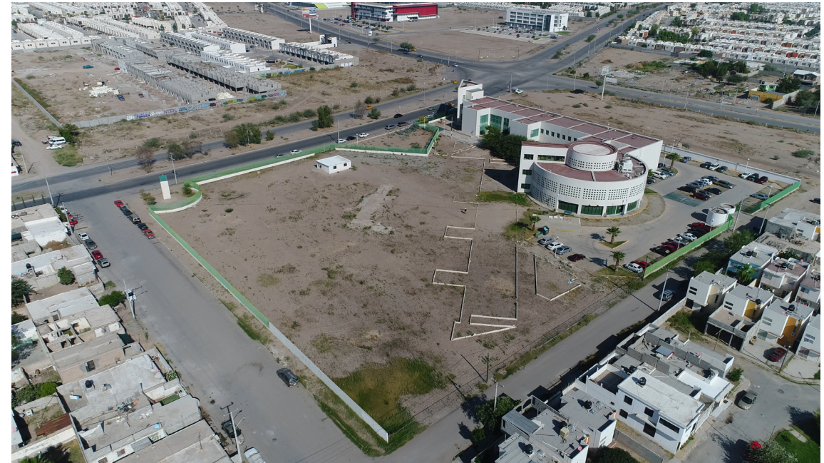
Panorámica del área destinada para la Construcción de Unidad de Medicina Familiar 10 consultorios con Atención Médica Continua, Municipio de Torreón, Coahuila.
