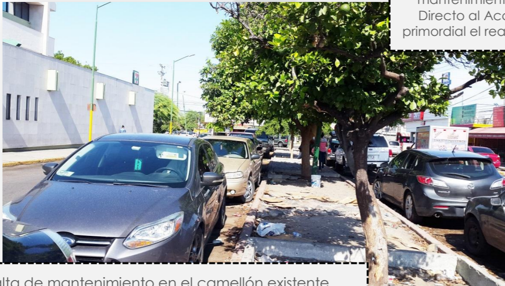
Falta de mantenimiento en el camellón existente.
