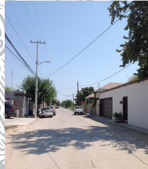
FIGURA 4.9. Línea eléctrica cercana al predio
