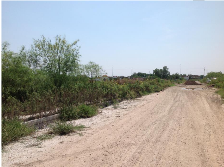
FIGURA 4.8.b Sin carpeta de rodamiento. Calle Francisco Javier Mina
