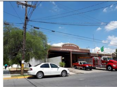
La estación de Bomberos en la Av. Metroplex en la zona es muy significativa.
