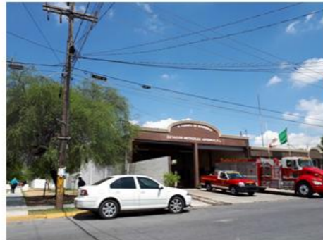
Estación de Bomberos en Av. Metroplex esq. N 25
