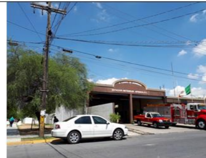
La estación de Bomberos en la Av. Metroplex en la zona es muy significativa.
