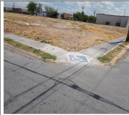
FOTOGRAFIA 01 En las cuatro esquinas alrededor del predio, se encuentran rampas para personas con discapacidad, mismas que se deben de cuidar al desarrollar el procedimiento constructivo del nuevo inmueble.
