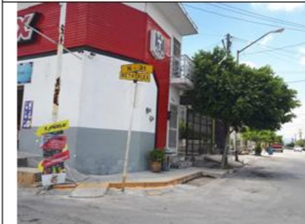
FOTOGRAFIA 05 Rampa para personas con discapacidad frente al costado Este del predio, calle N 31 esq. Av. Metroplex.
