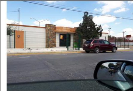
Dentro de los usos de suelo en la zona, encontramos una Biblioteca en Av. Metroplex, entre calle Galaxia.
