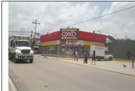
FOTOGRAFIA 01 Tienda de conveniencia "OXXO", ubicada sobre la calle Nezahualcóyotl a dos calles al norte del predio.
