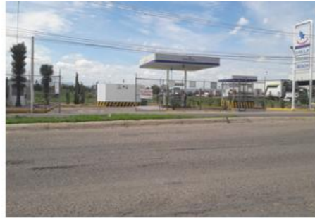
FOTOGRAFIA 04 Estación de gas, sobre la carretera Durango Nombre de Dios.
