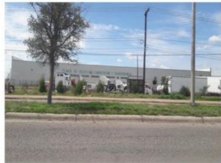
FOTOGRAFIA 06 Planta de Selección, Compactación y Transferencia de Residuos Sólidos Urbanos del Municipio de Durango-
