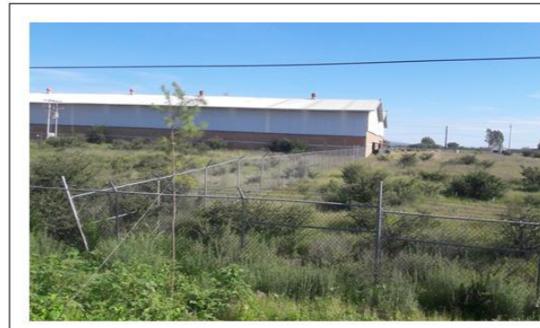
COSTADO OESTE Colinda con el Almacén Delegacional del IMSS de Durango.
