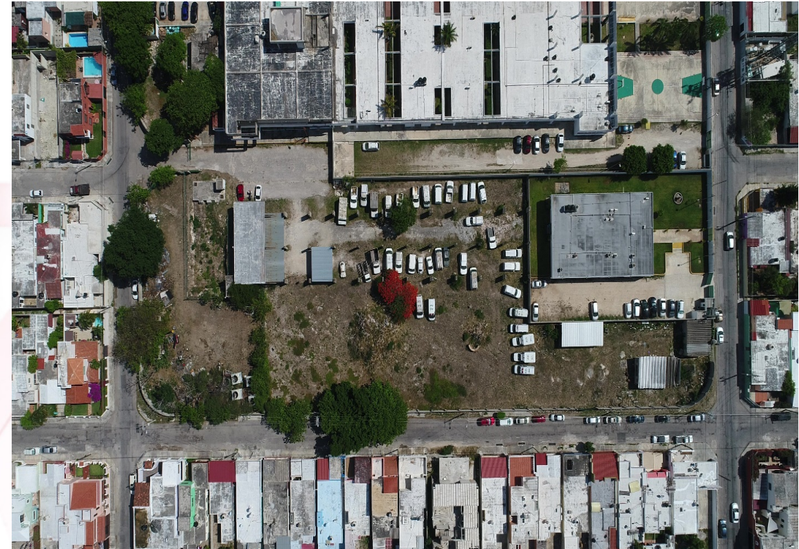
Panorámica del área destinada para la Construcción de la clínica para la detección y diagnóstico de cáncer de mama estará ubicado en el municipio de Mérida, Yucatán.
