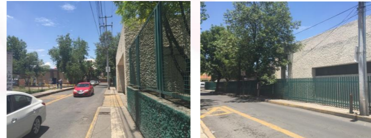
Postes y cableado de media tensión en calle Benito Juárez.
