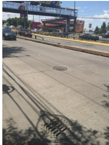
Brocal de pozo de visita de la línea de drenaje que pasa bajo la Av. López Portillo y que dará servicio frente nuestro predio.
