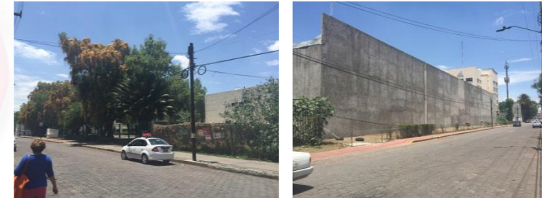
Líneas de alta y baja tensión, alumbrado público en calle José María Morelos.
