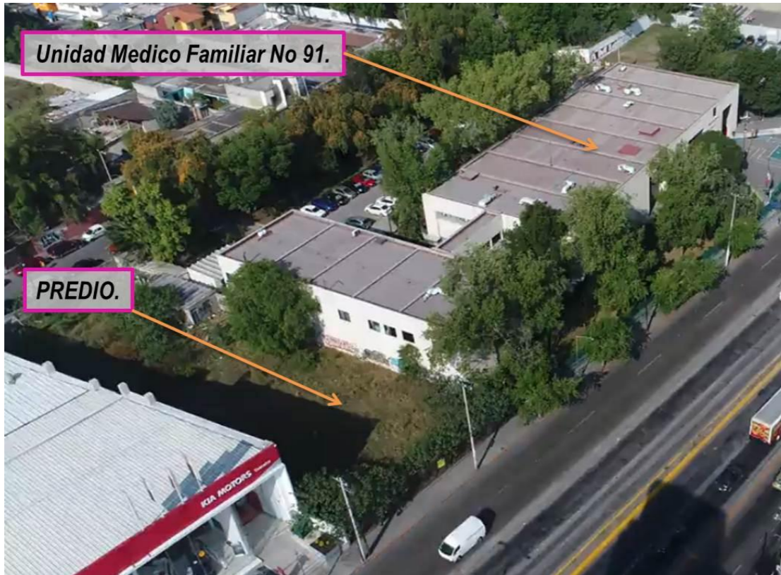
UMF No. 91 vista desde Vía López Portillo.
