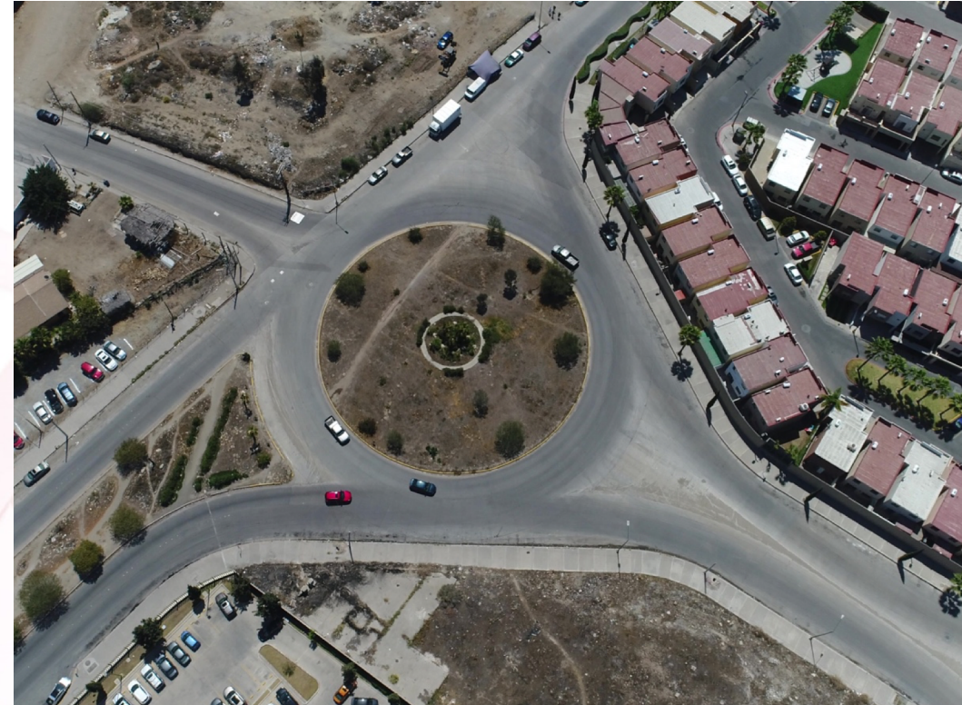
Panorámica de la intersección Paseo del Rio con Av. Campos, dos vialidades que brindaran servicio de acceso al proyecto.
