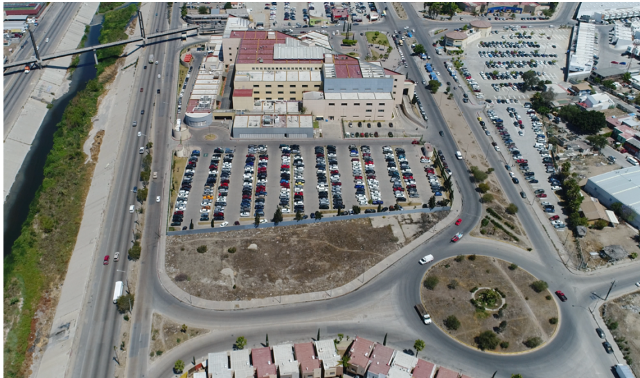
Vista Panorámica y Aérea de la manzana donde se ubicará el proyecto con vista de sur a norte.
