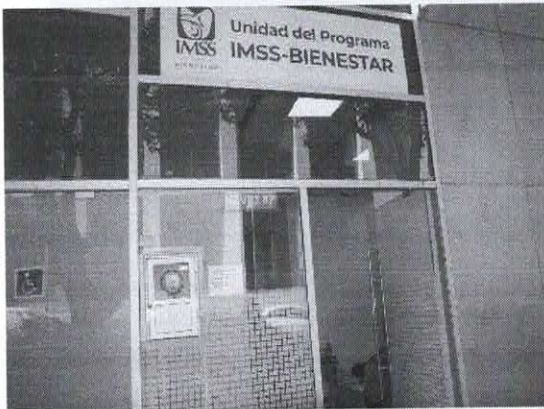
ACCESO PRINCIPAL AL INMUEBLE
