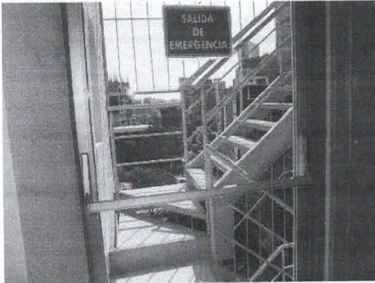
ESCALERA DE EMERGENCIA
