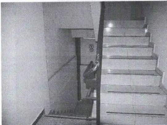
ESCALERA DE PLANTA BAJA A SÓTANO
