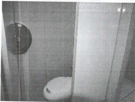
VISTA INTERIOR DE SANITARIO
