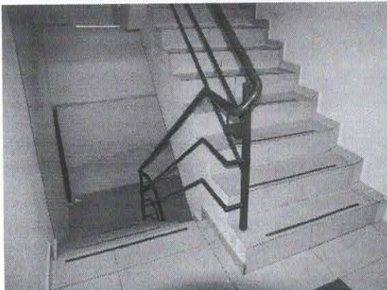
VISTA DE ESCALERA
