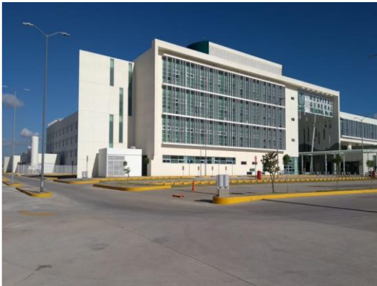
Situación actual de la obra:
