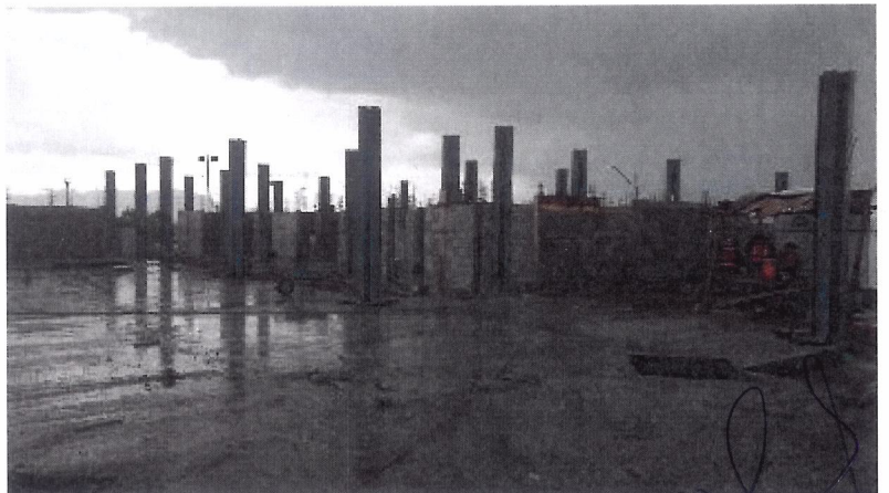
Suspensión de los trabajos de habilitado, soldadura y montaje de estructura de acero. Debido al riesgo que se presenta con el agua y la imposibilidad de hacer trabajos de soldadura con el mismo.
