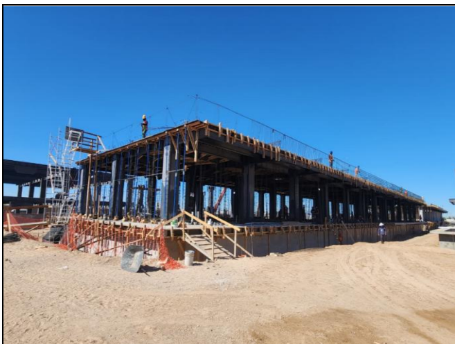
TRABAJOS DE ALBAÑILERÍAS EN LOSA DE ENTREPISO Y COLADO DE CAPA DE COMPRESIÓN EN LOSA DE AZOTEA EN CUERPO DE SERVICIOS GENERALES
