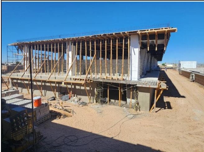
TRABAJOS DE ALBAÑILERÍAS EN LOSA DE ENTREPISO Y COLADO DE CAPA DE COMPRESIÓN EN AZOTEA EN CUERPO DE CASA DE MÁQUINAS
