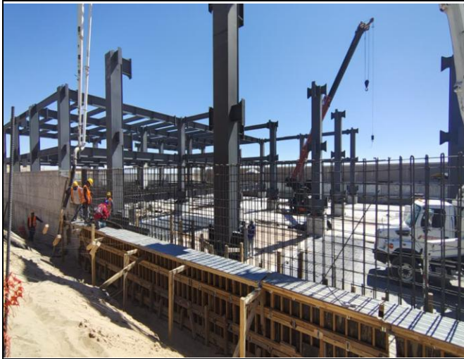
MONTAJE DE ESTRUCTURA METÁLICA, ARMADO Y COLADO DE MUROS DE CONFINAMIENTO Y DE FIRMES EN CUERPO DE ESTACIONAMIENTO
