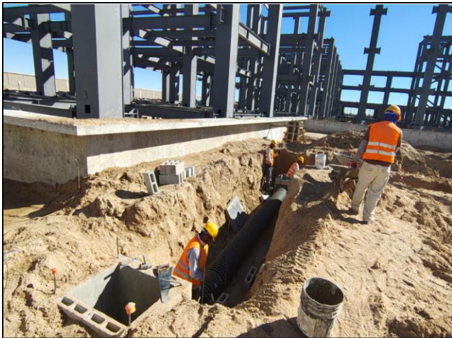
TRABAJOS DE TERRACERÍAS, ARMADO DE REGISTROS Y TENDIDO DE TUBERÍAS SANITARIAS EN OBRAS EXTERIORES
