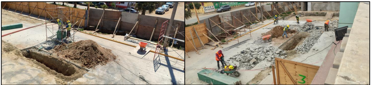
Demolición de elementos de fachadas y retiro del material producto de las demoliciones.
