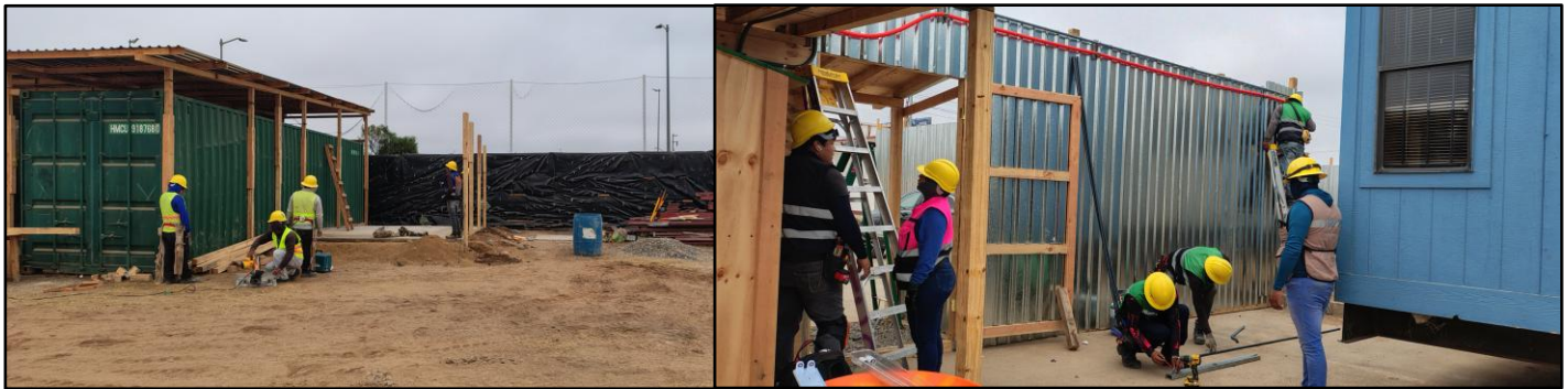
Construcción de oficinas y bodegas provisionales.
