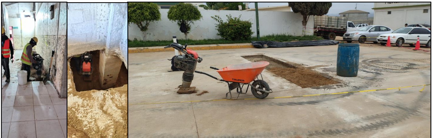
Relleno de áreas de muestreo para mecánica de suelos.
