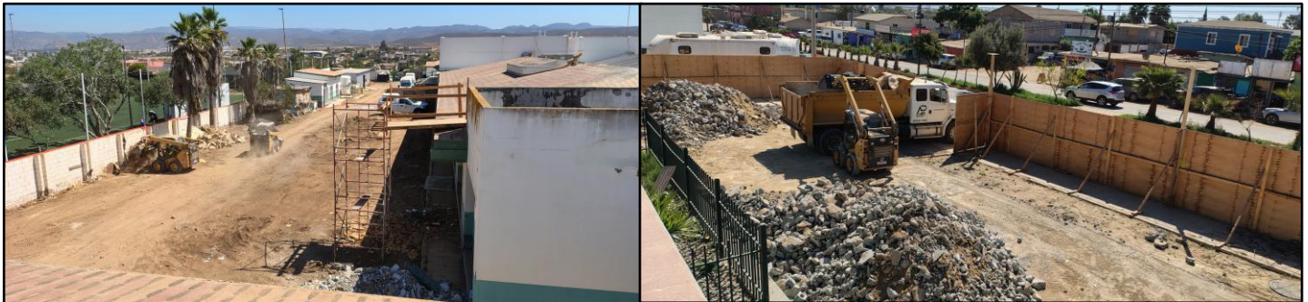
Acopio y retiro de material producto de las demoliciones.
