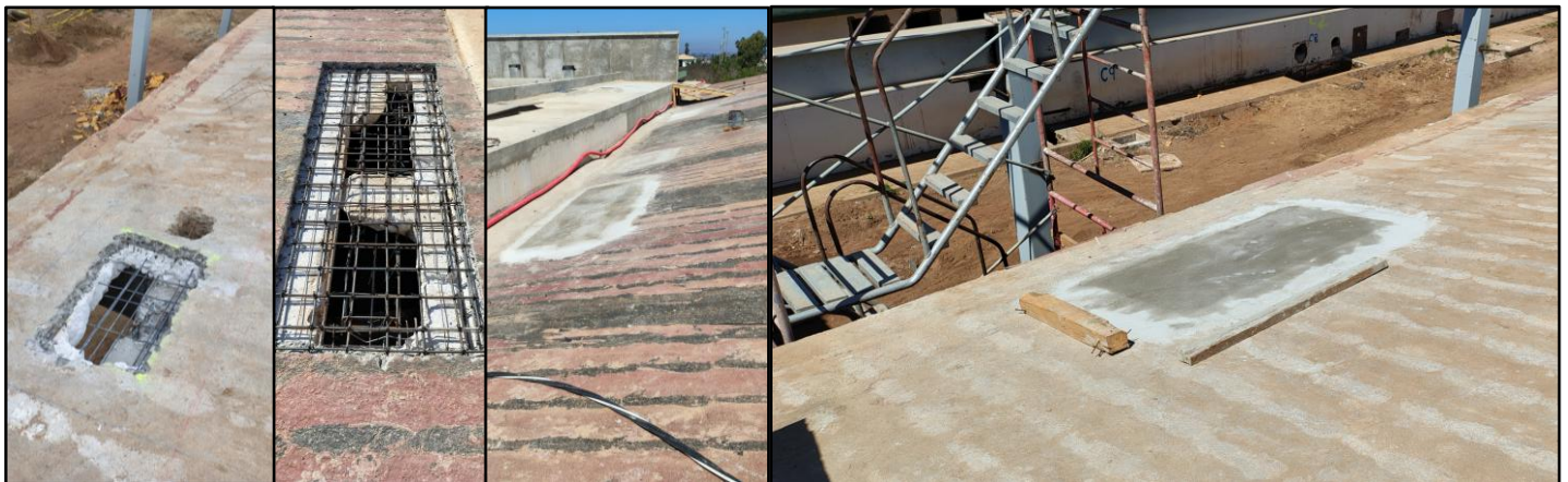
Refuerzo y resane de huecos en losas de azotea realizados para inspección de la estructura.
