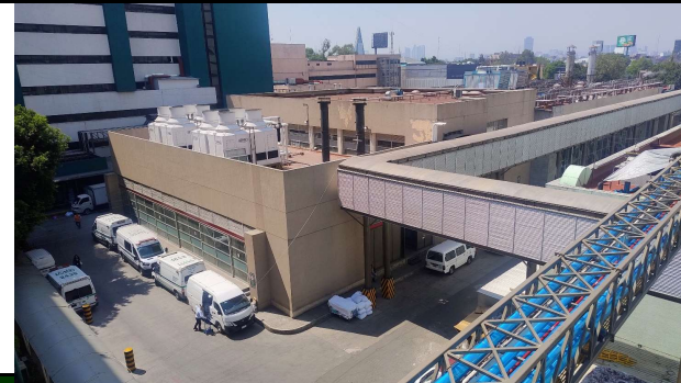
PROBLEMÁTICA Y PENDIENTES DE OBRA Y ADMINISTRATIVOS.
