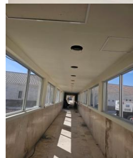
Preparacion para luminarias en comedor
