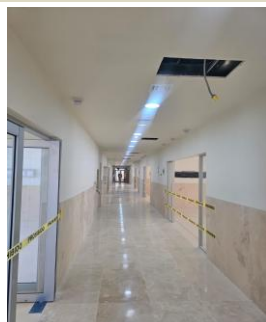
Instalacion de luminarias por pasillos
