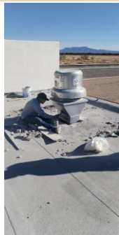
instalacion de extractores tipo homgo
