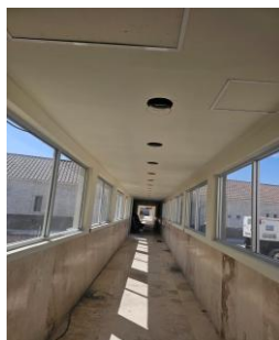
Preparacion para luminarias en pasillos
