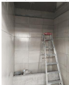
Instalacion de Vitro muro en cuarto de aseo
