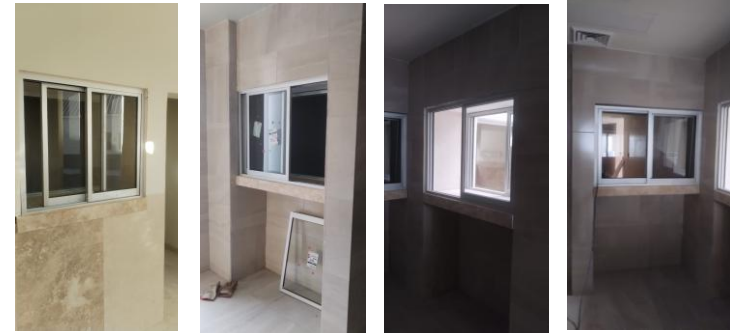
Instalacion de Exclusas en area de CEYE
