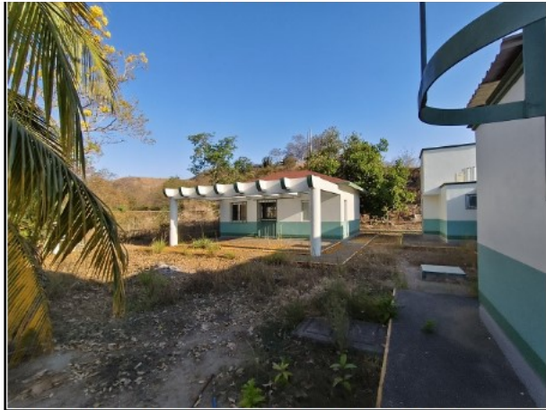
FACHADA ACCESO A CENTRO DE ATENCION A LA SALUD DEL ADOLESCENTE
