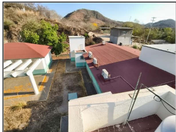
ASPECTO DE CUBIERTAS
