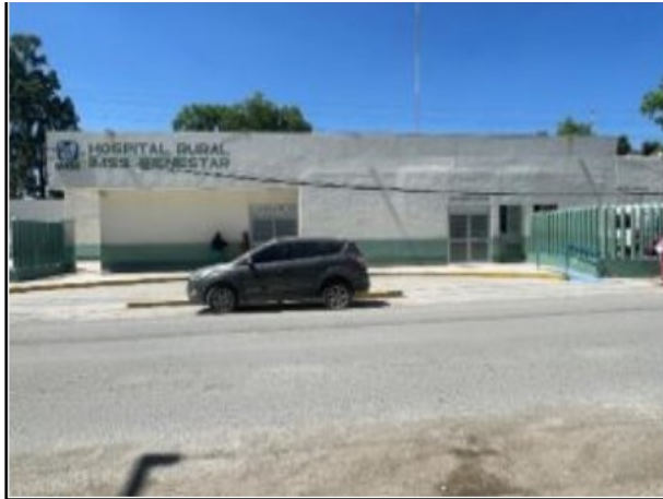
FACHADA DE URGENCIAS
