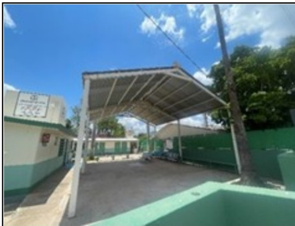
Estructura metálica - cobertizo
