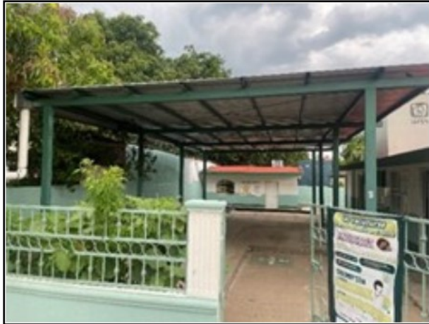
Estructura metálica - cobertizo
