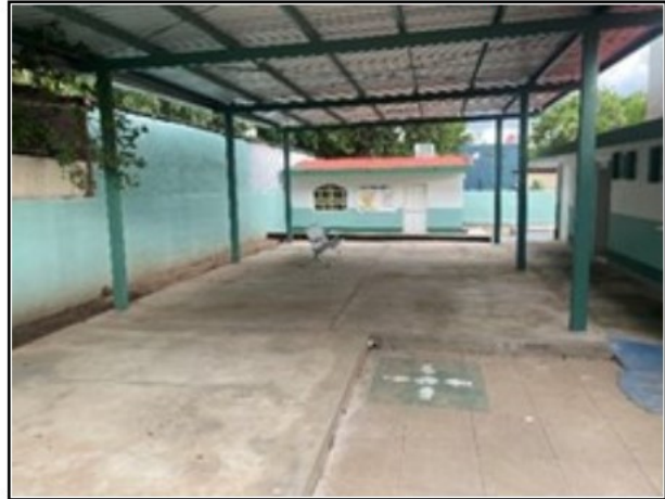
Interior estructura metálica - cobertizo
