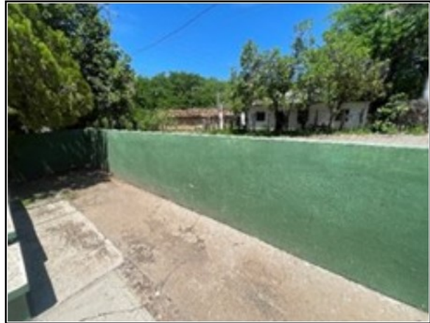
Barda perimetral al terreno
