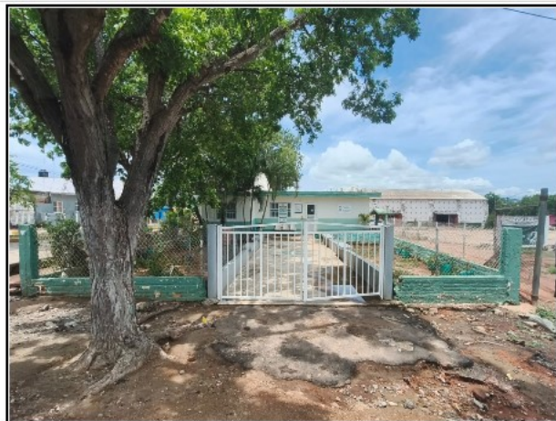
FACHADA DEL INMUEBLE
