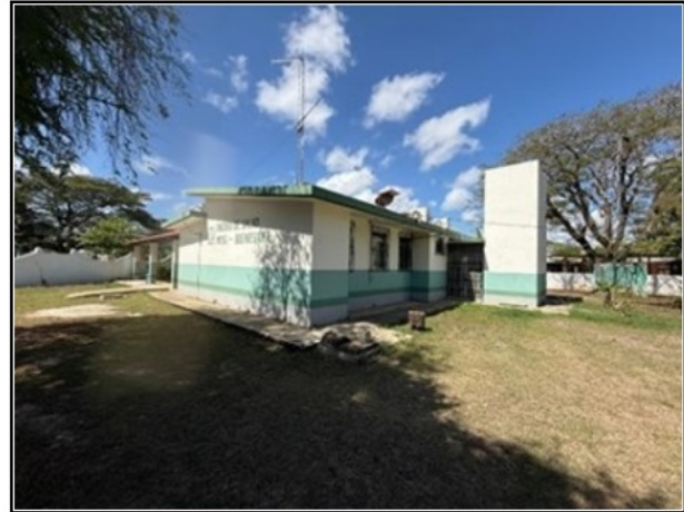
VISTA GENERAL DEL ACTIVO
