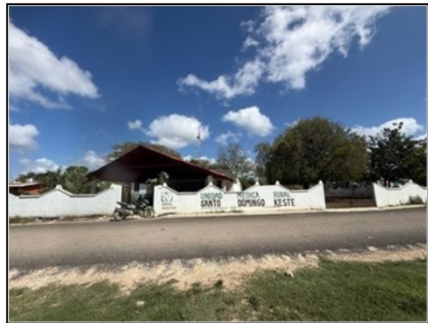
VISTA GENERAL DEL ACTIVO
