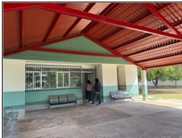
VISTA GENERAL DEL ACTIVO
