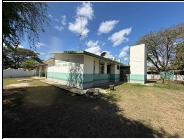
VISTA GENERAL DEL ACTIVO
