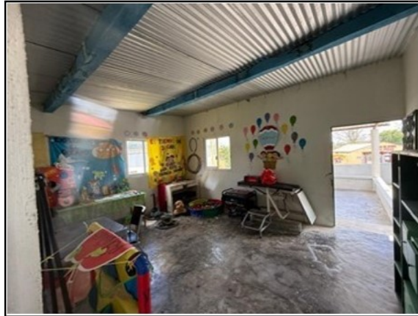
VISTA GENERAL DEL ACTIVO
