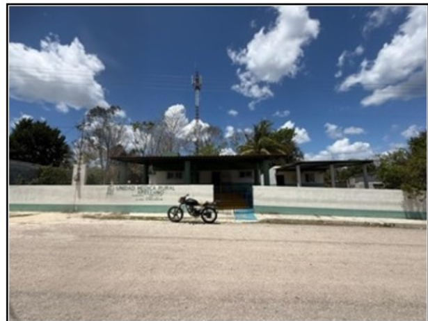
VISTA GENERAL DEL ACTIVO
