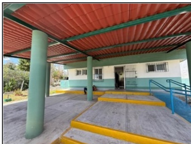
VISTA GENERAL DEL ACTIVO
