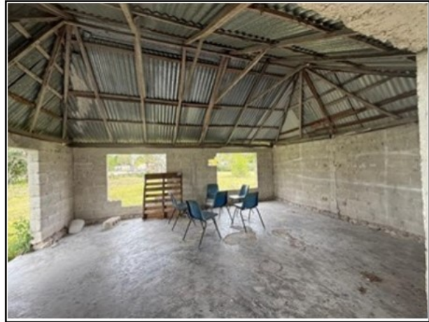
VISTA GENERAL DEL ACTIVO
