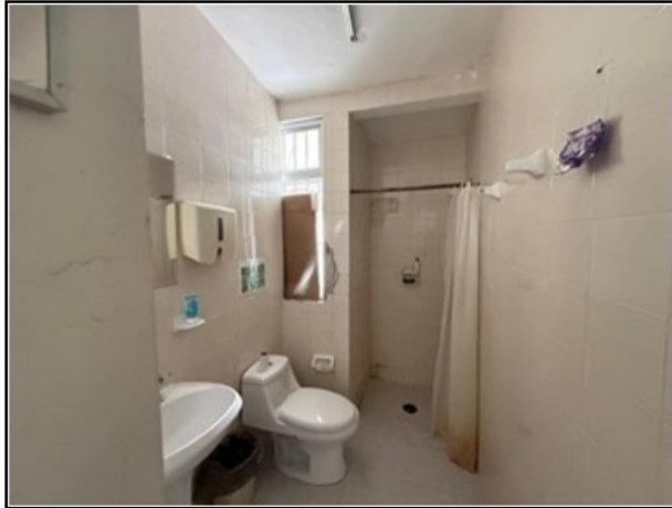
VISTA GENERAL DEL ACTIVO
