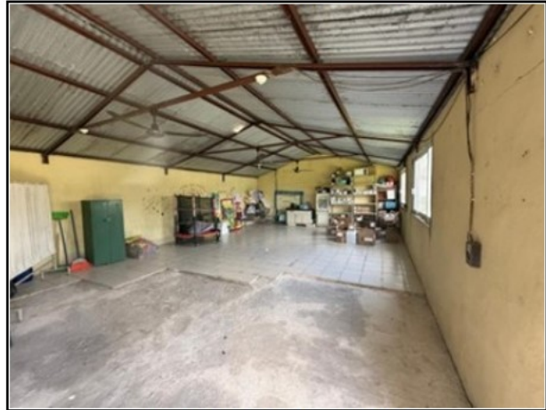
VISTA GENERAL DEL ACTIVO
