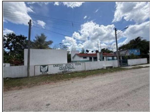
VISTA GENERAL DEL ACTIVO
