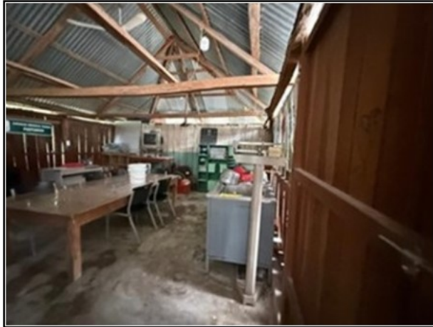
VISTA GENERAL DEL ACTIVO
