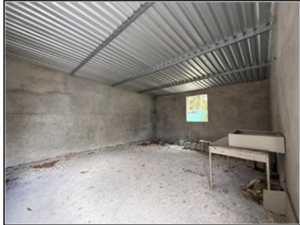
VISTA GENERAL DEL ACTIVO
