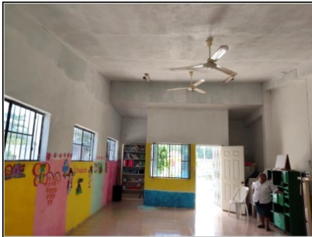
VISTA INTERIOR DEL ACTIVO
