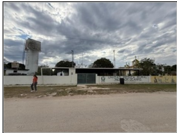
VISTA GENERAL DEL ACTIVO
