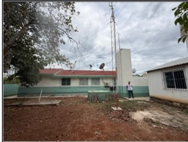
VISTA GENERAL DEL ACTIVO
