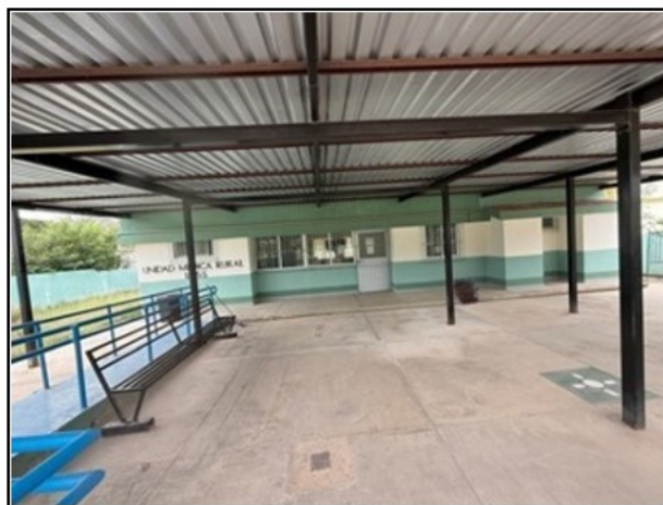
VISTA GENERAL DEL ACTIVO
