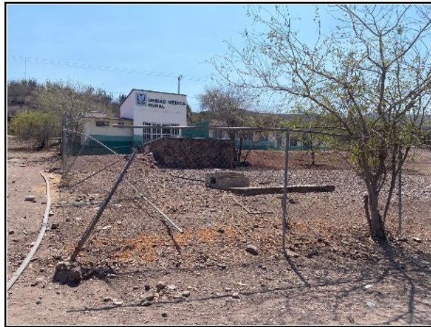
FACHADA DE ACCESO
