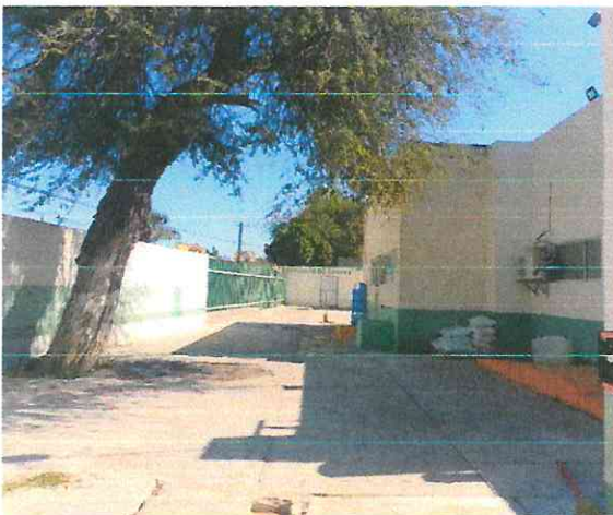
Los firmes de la parte trasera de la clínica están en buen estado, solo existe poca presencia de vegetación nociva entre las juntas.
