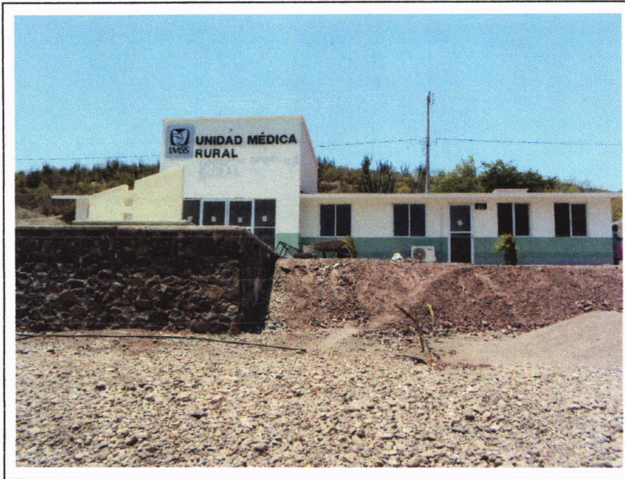
FACHADA PRINCIPAL DE LA UNIDAD MEDICA RURAL IMSS - BIENESTAR, UBICADA EN JAZMIN CUAUIITEMOC, QUE FUE REVISADA DESPUES DEL SISMO.
