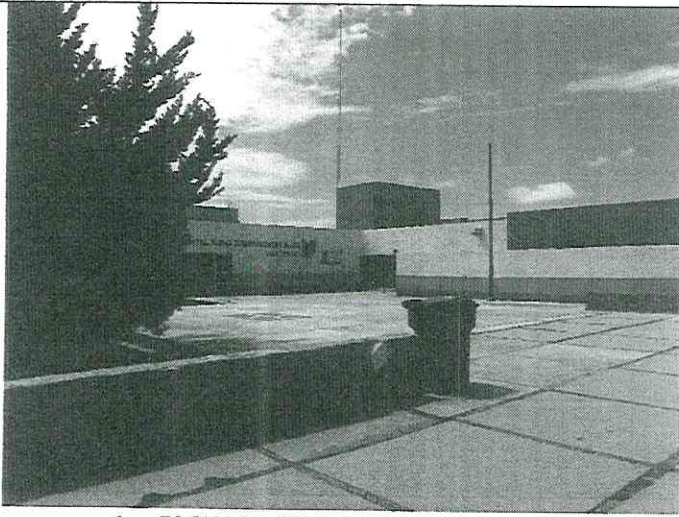
1. FACHADA EXTERIOR ACCESO PRINCIPAL
