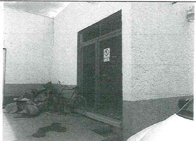
150. ACCESO PLANTA DE EMERGENCIA
