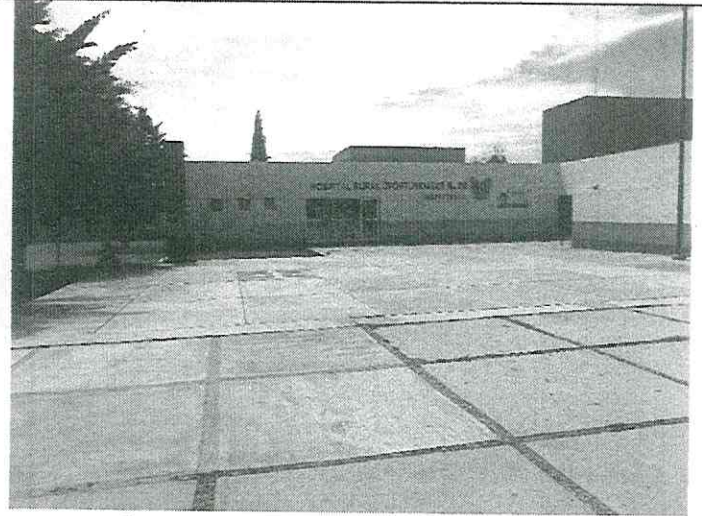
2. FACHADA EXTERIOR ACCESO PRINCIPAL
