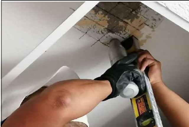
Fotografía 7. Sala de espera
