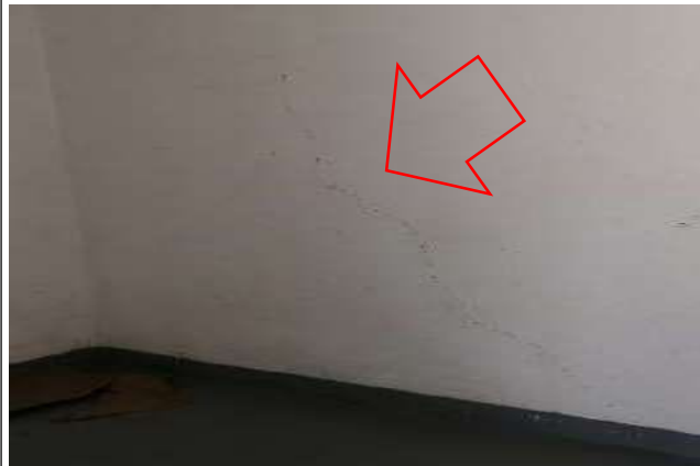
Fotografía 19. Servs. Gales. Pasillo (por cocina)
