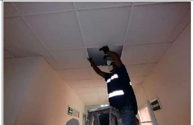
Fotografía 30. Hospitalización. Pasillo a Cocina Auscultación de la estructura.
