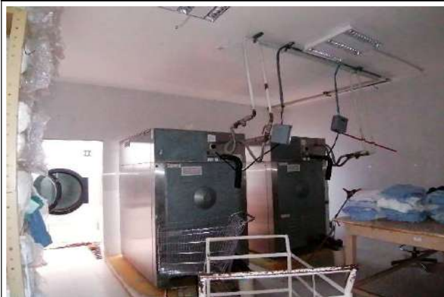
Fotografía 25. Servs. Grales. Lavandería Sin observaciones en muros y pisos.
