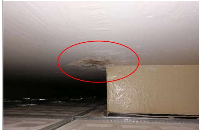
Fotografía 32. Hospitalización. Pasillo a Cocina. Obsérvese manchas por oxidación de acero de refuerzo, abultamiento y eflorescencias.
