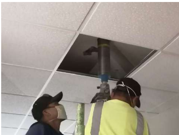
Fotografía o . Extracción invertida de núcleo de concreto en losa.
