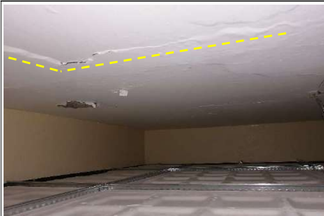
Fotografía 59. Hospitalización. Sala de labor
