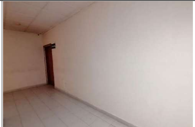
Fotografía 18. Servs. Gales. Pasillo (por cocina)
