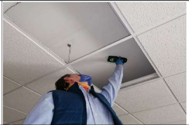
Fotografía 6. Sala de espera
