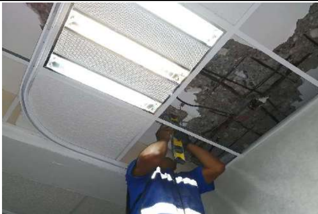
Fotografía 51. Hospitalización. Sala de labor Obsérvese despasivación del acero de refuerzo por corrosión uniforme o generalizada.
