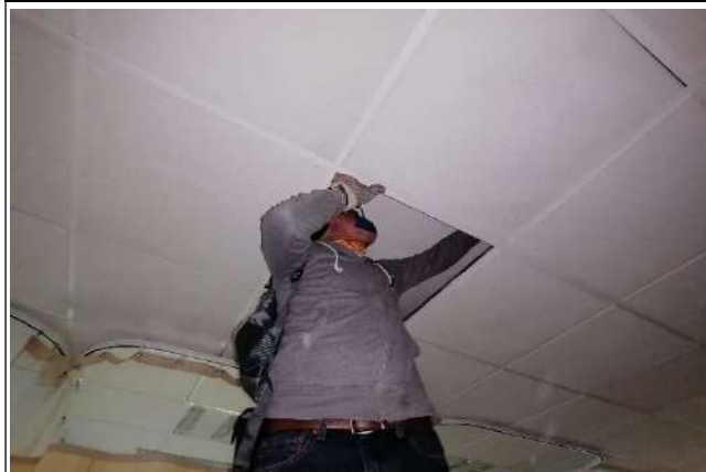
Fotografía 43. Hospitalización. Urgencias Inspección de losa.
