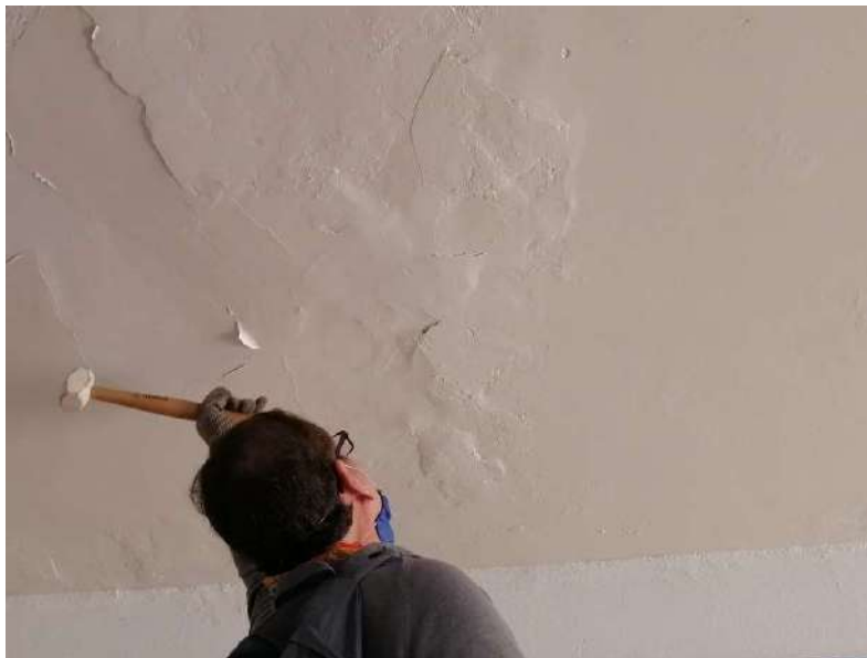
Fotografía n. Estudio mediante martillo acústico
