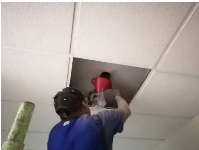
Fotografía l. Obtención de muestra de material de relleno sobre losa de azotea.
