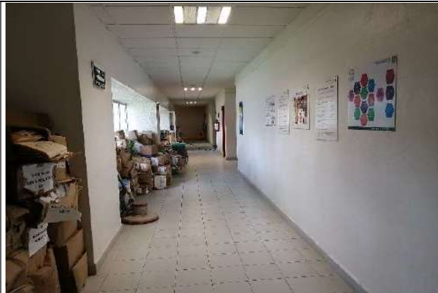
Fotografía 17. Servs. Gales. Pasillo
