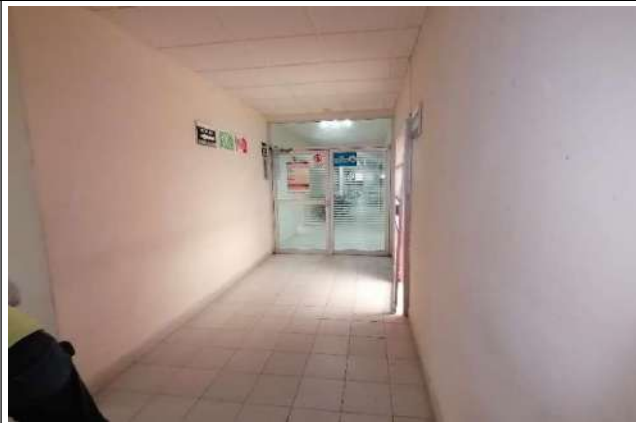
Fotografía 29. Hospitalización. Pasillo a Cocina Sin observaciones en pisos y muros.
