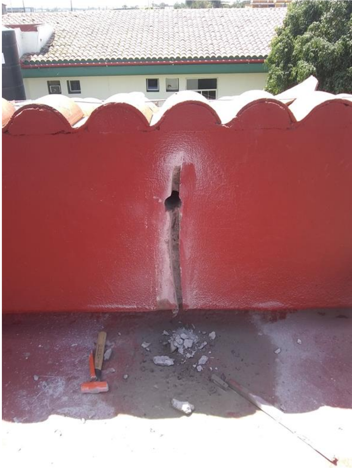
Aspecto general de los trabajos en trabes para conocer determinar el tipo de armado.
