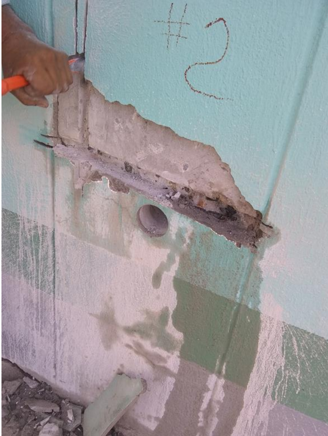
Proceso para abrir venas en columnas.
