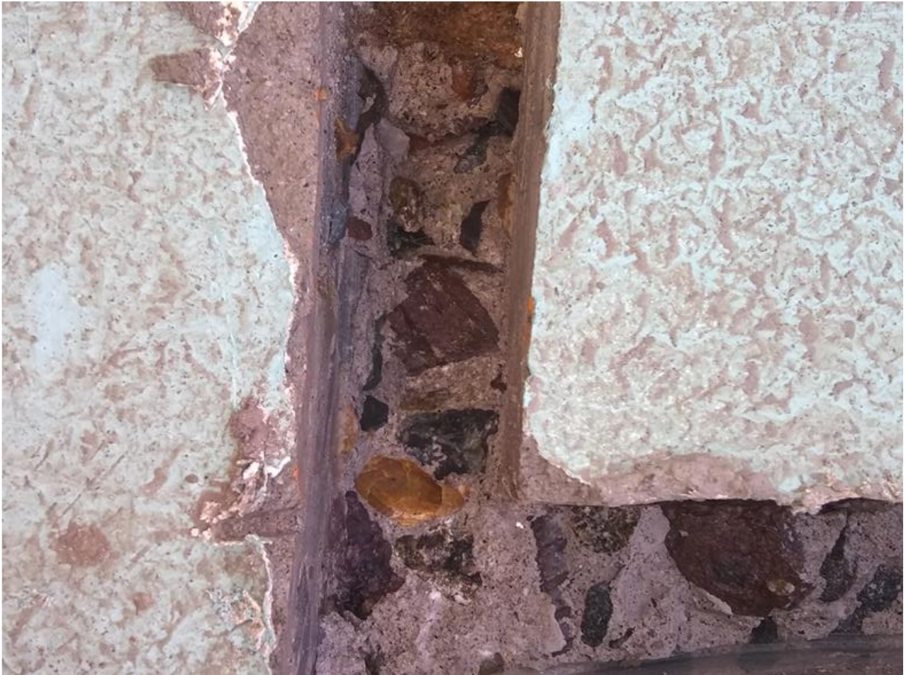
Acercamiento de las venas para visualizar el tipo de acero de refuerzo.
