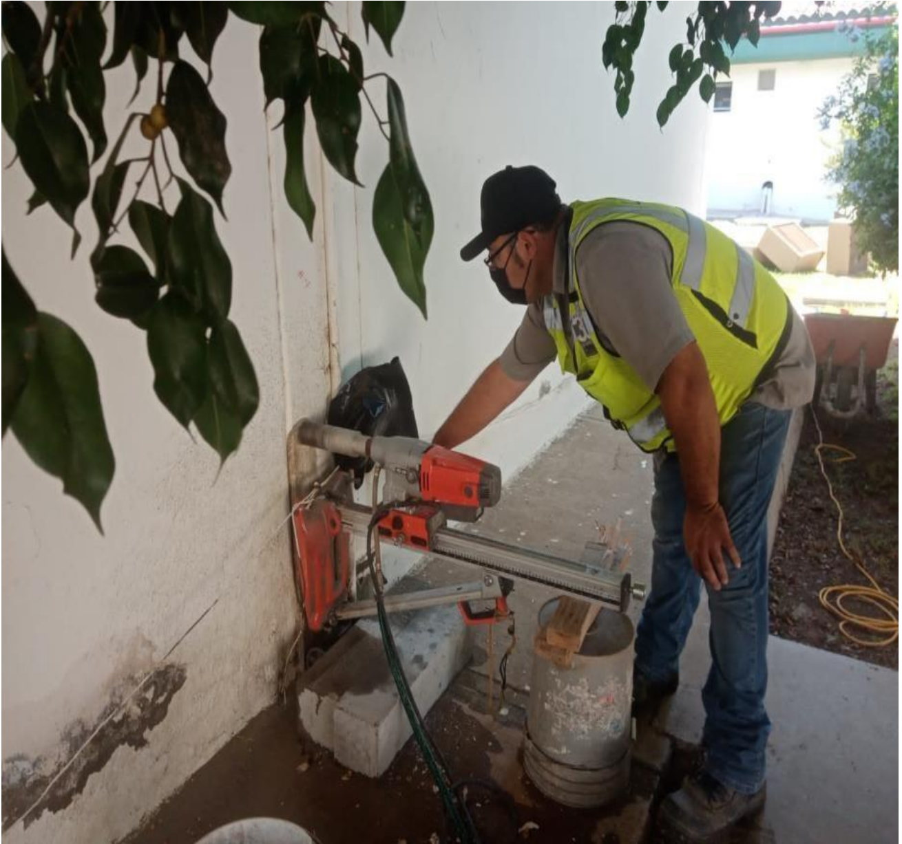
Tomando muestras en junta constructiva
