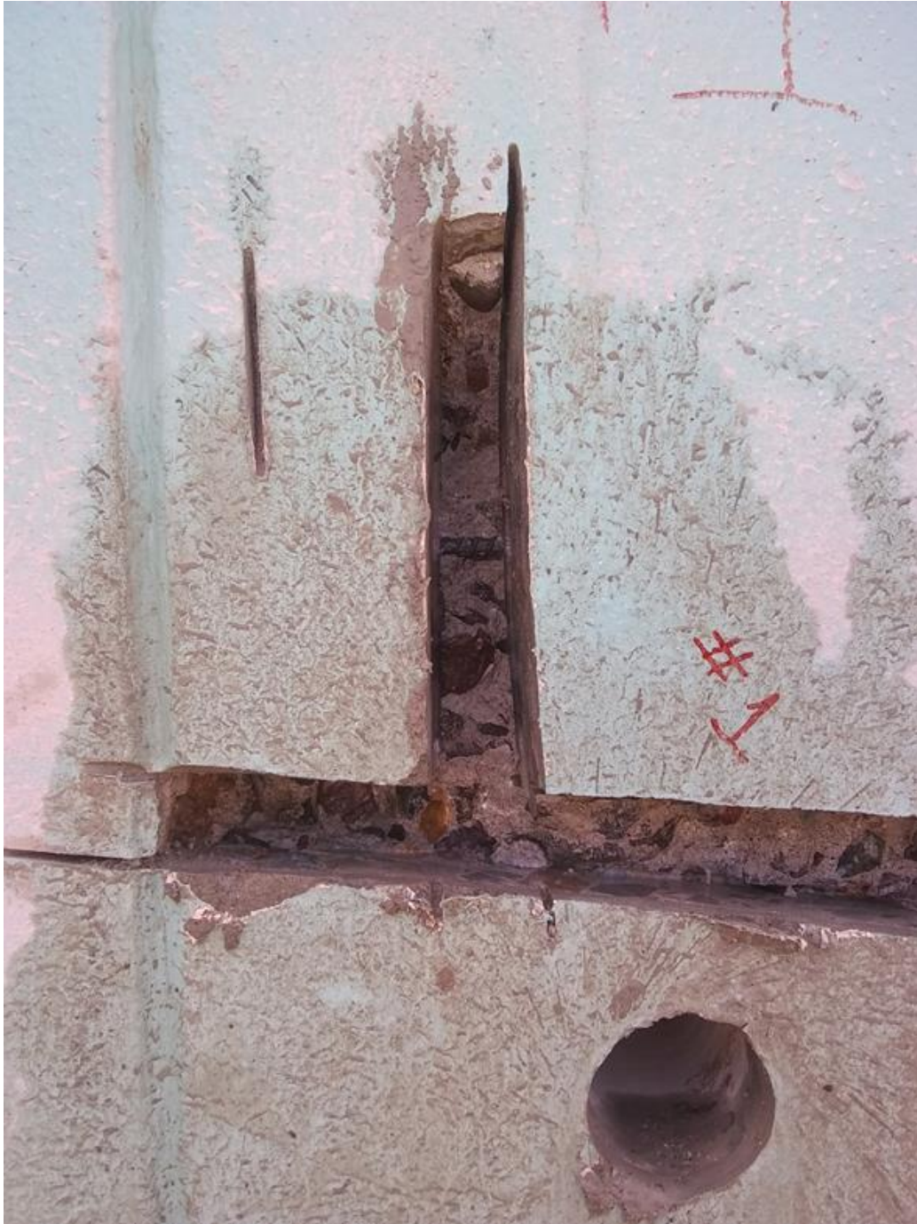
Nótese los estribos que se localizan a cada 20 cm.
