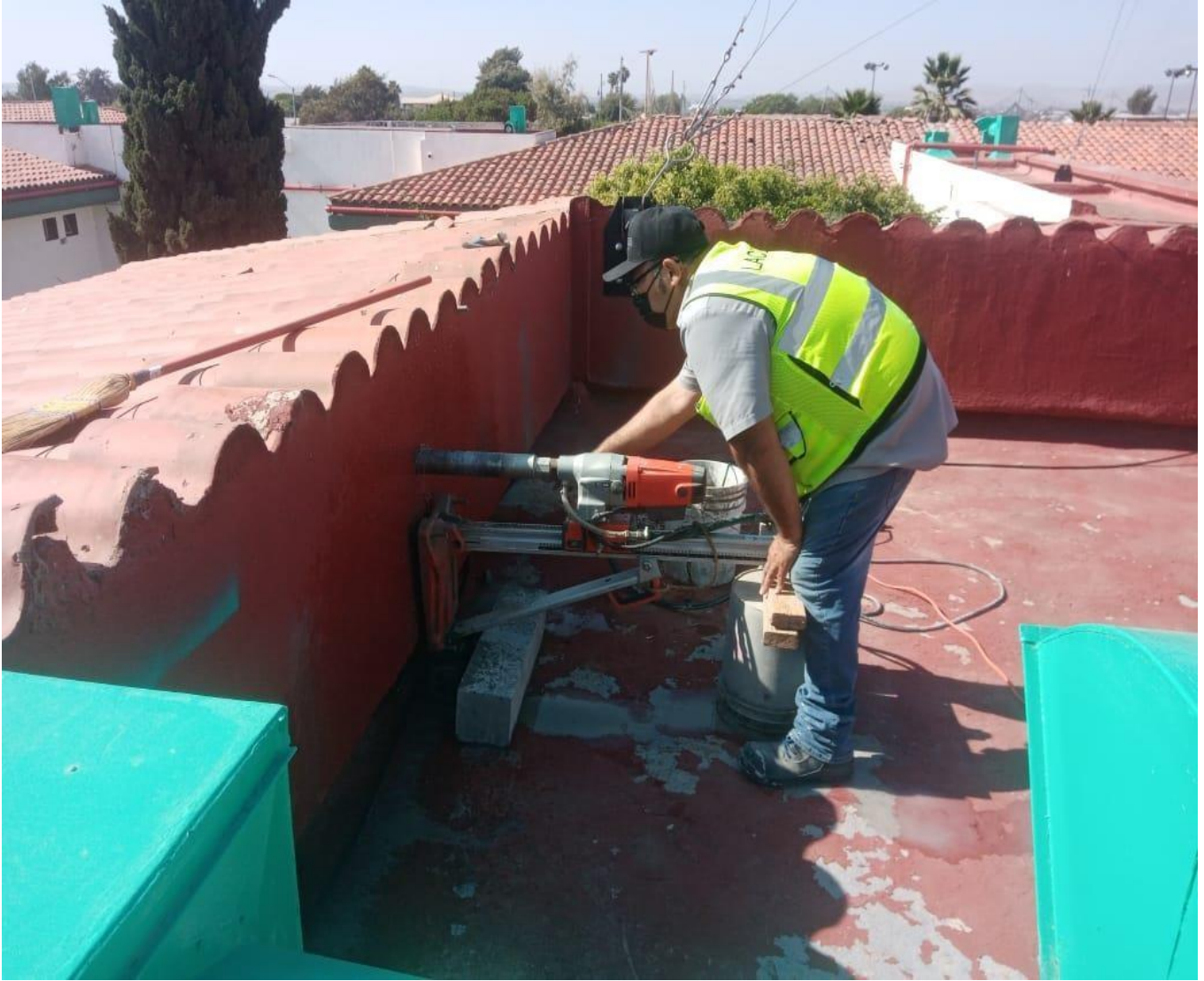
Extrayendo “muestra” en trabe de losa plana sobre el área de Tococirugía.
