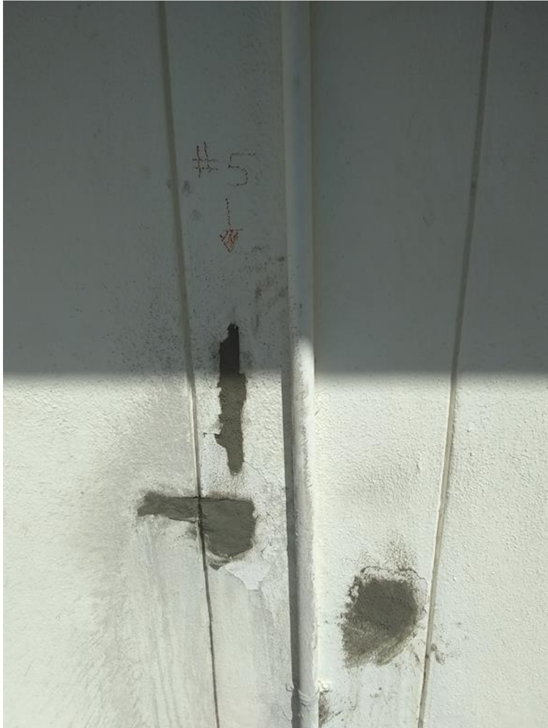
Reparación de las calas y perforaciones que se realizaron en columnas, se utilizó estabilizador de volumen para tapar dichas perforaciones.
