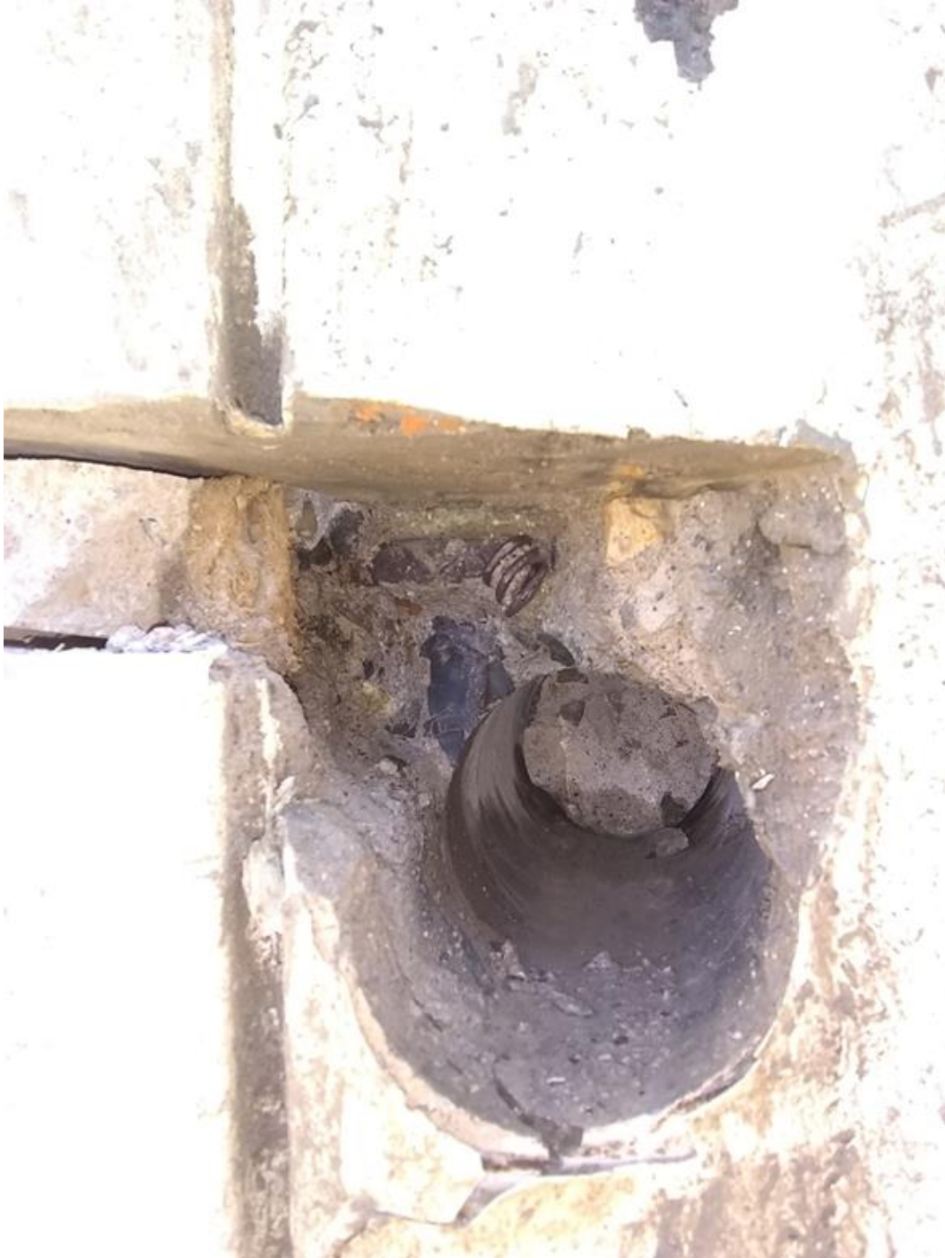
Venas en columna, nótese el acero de refuerzo principal amarrado con alambre recocido
