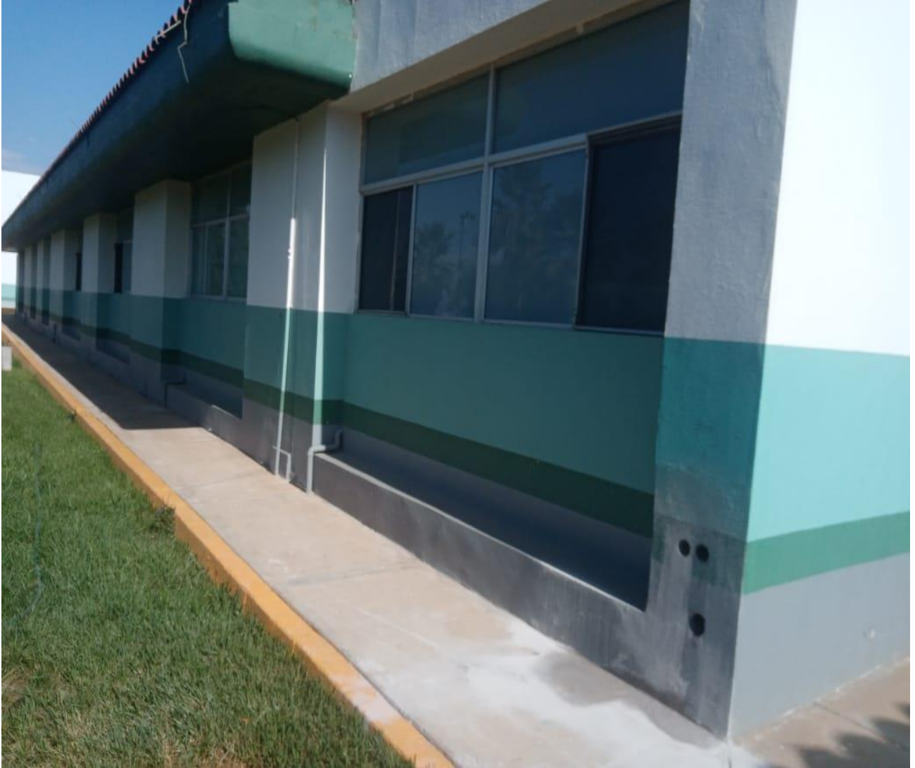
Columna en donde se encontró el acero de refuerzo y se tuvieron que hacer tres intentos para sacar el núcleo de concreto.
