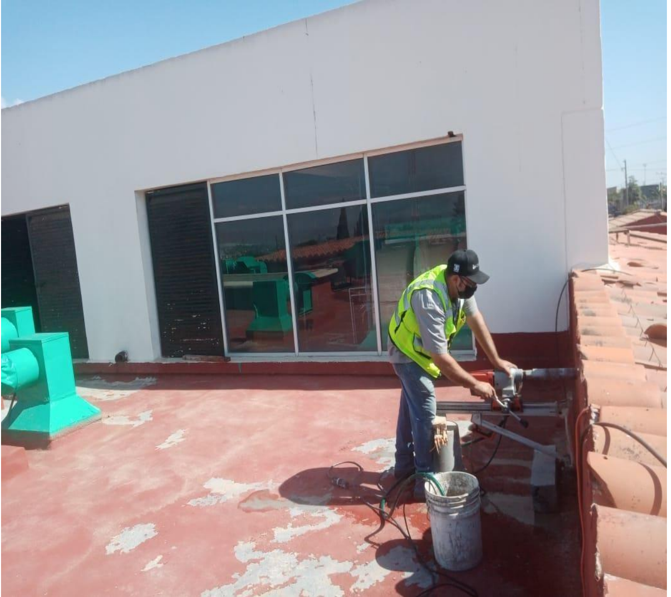
Extracción de núcleo en azotea sobre el área de Tococirugía.
