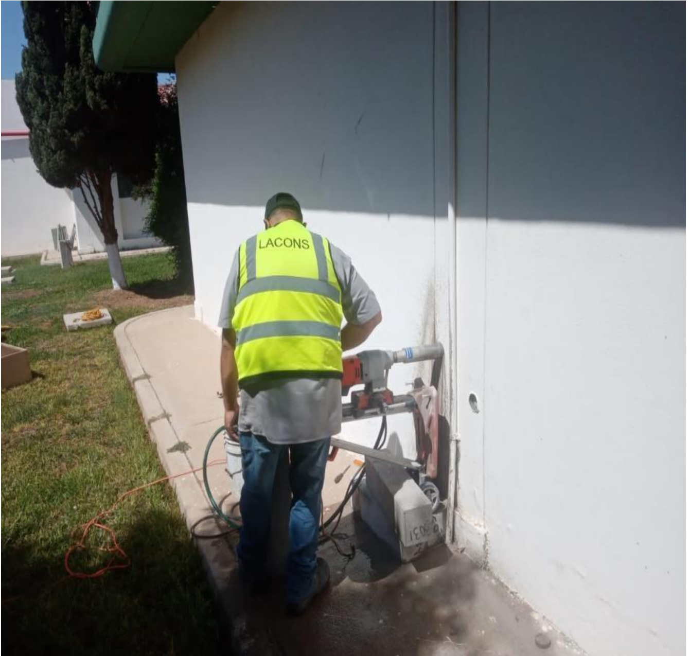
Extracción de los núcleos de concreto.
