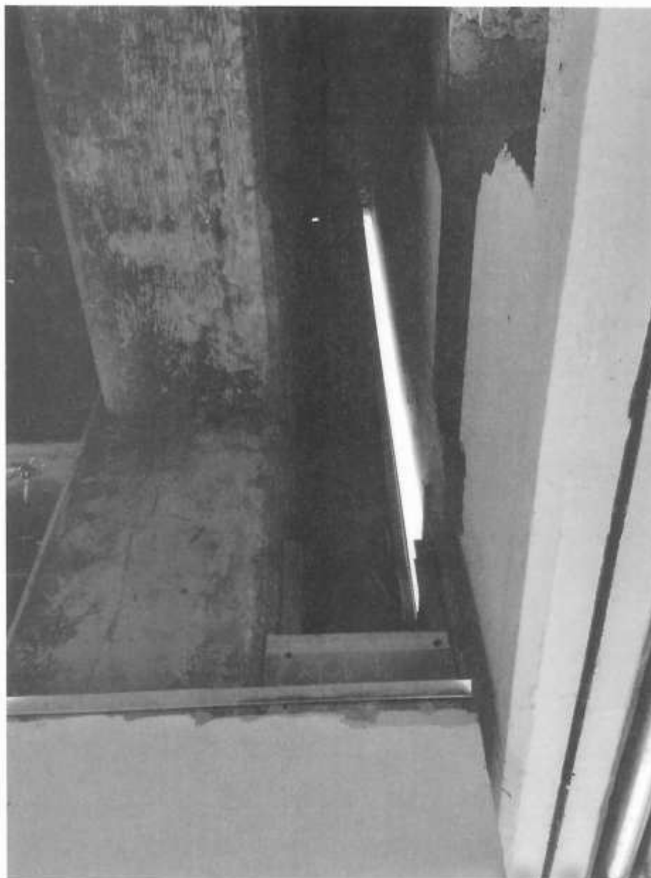
Fotografía 5. Junta constructiva entre Edificio Principal Consultorios y estructura que sube el pasillo que comunica el edificio antes mencionado y el Edificio de mayor a 5 cm. CUMPLE
