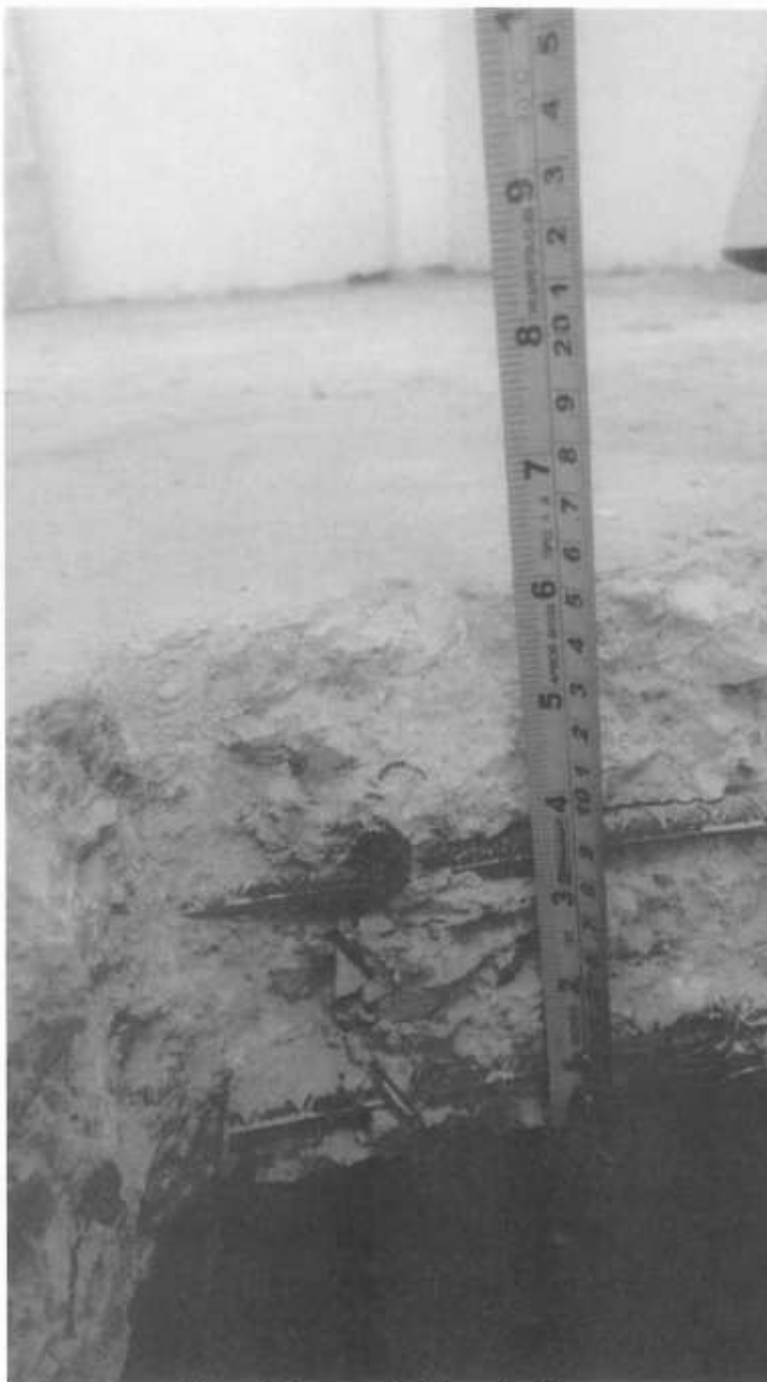
Figura 5. Espesor de la losa de 15 cm.
