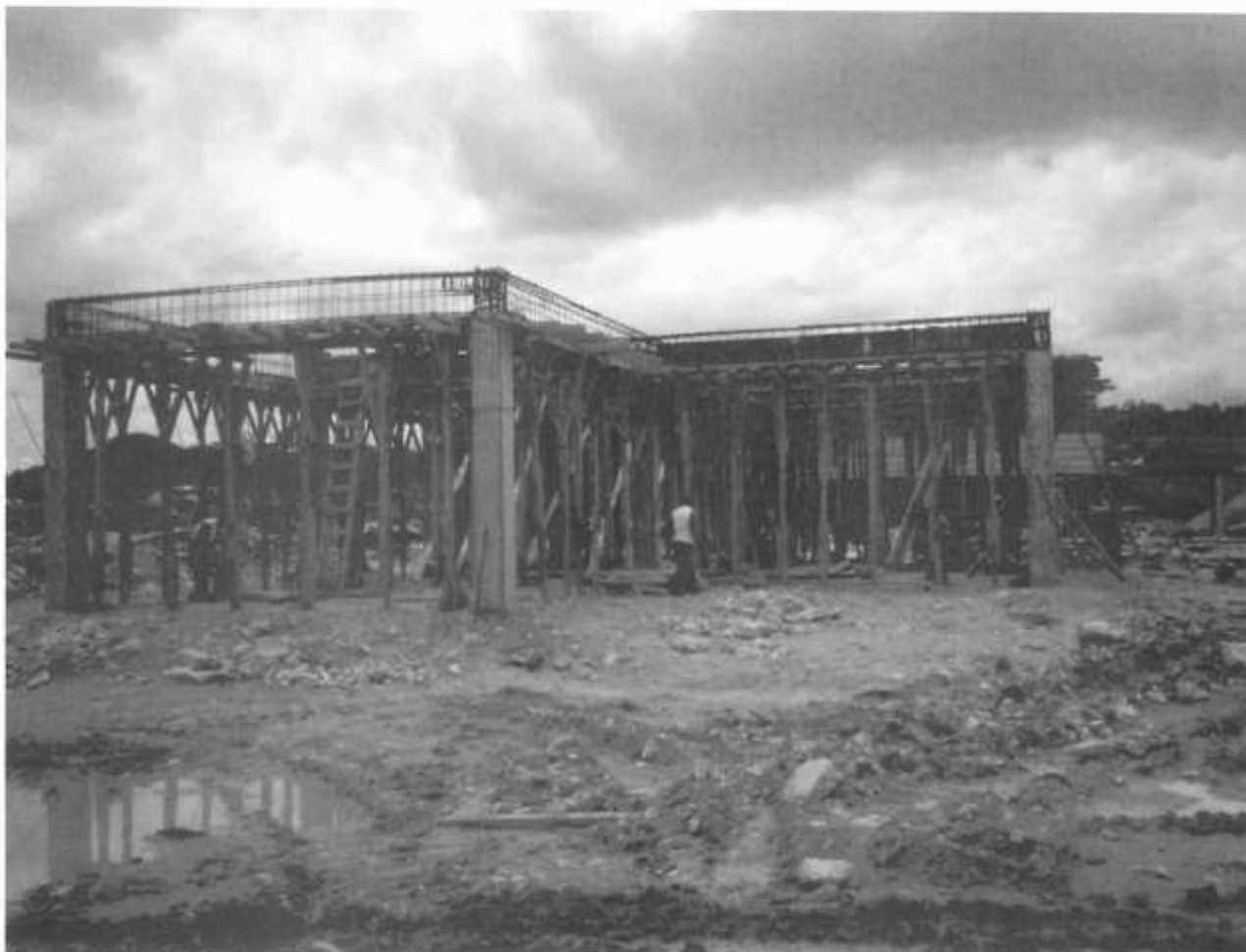
Fotografía 6. Cimbra suficientemente rígida para evitar roturas y deformaciones en su longitud
