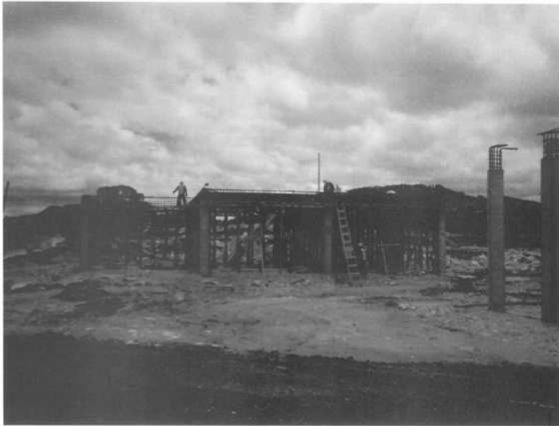
Fotografía 5. Vista frente armado de vigas de concreto
