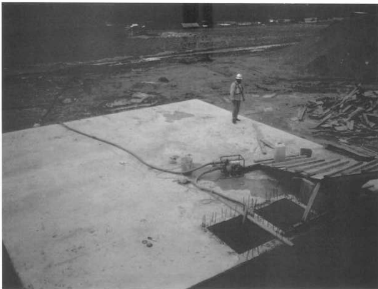
Fotografía 12. Descimbrado de losa
