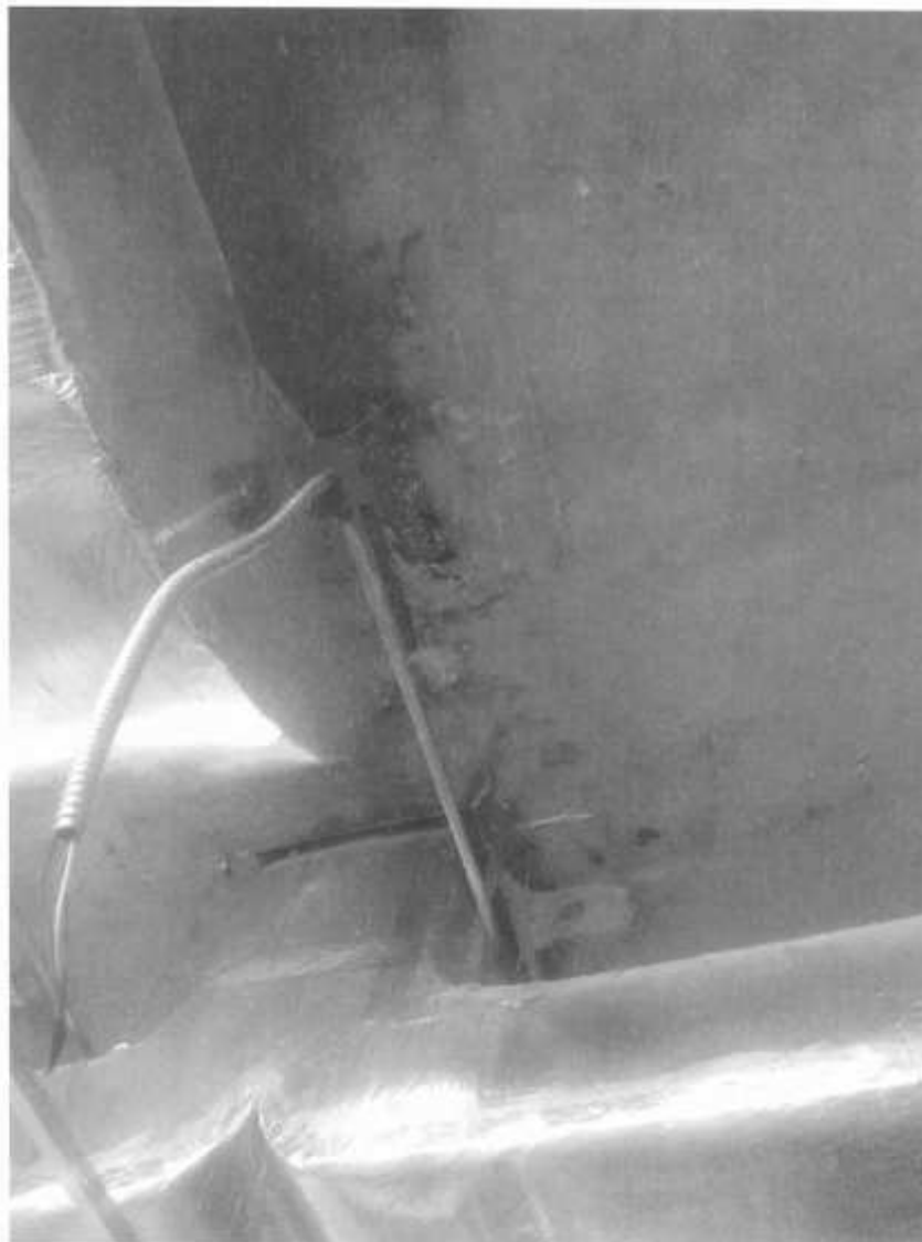
Fotografía 6. Apanalamiento en losa. No pone en riesgo la seguridad del edificio.
