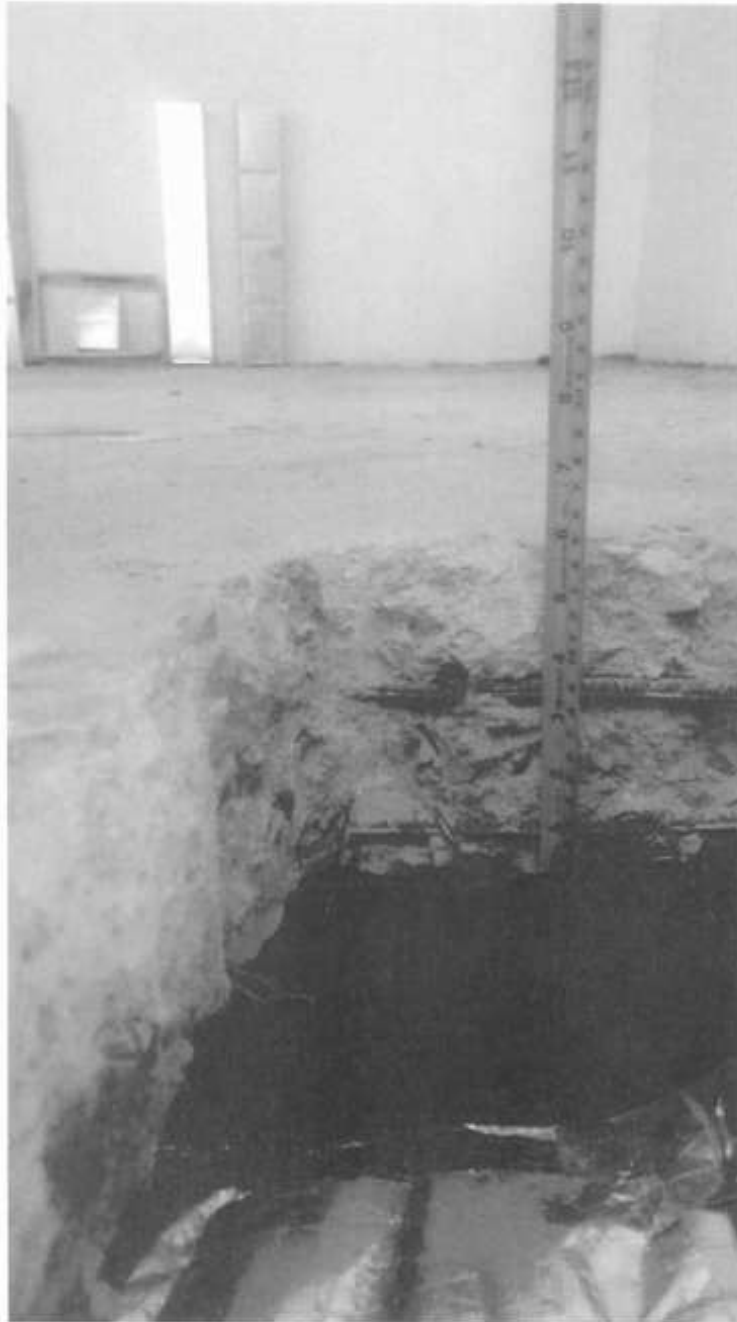
Figura 6 Se miden recubrimiento del lecho inferior y superior de la losa.
