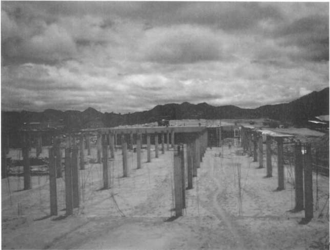
Fotografía 4. Desenconfrado de cimbra de madera en columnas
