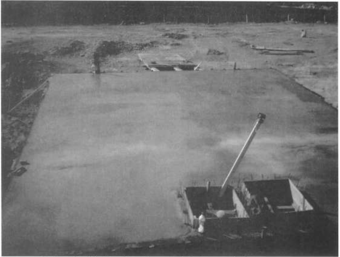
Fotografía 13. Curado en losa en toda la superficie.
