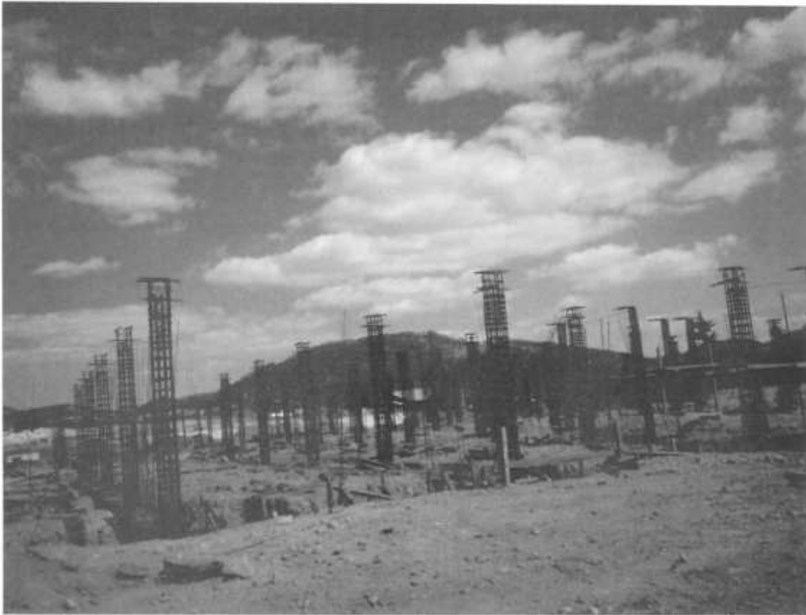
Fotografía 2. Excavación y posterior colocación de armadura a parilla de la cimentación
