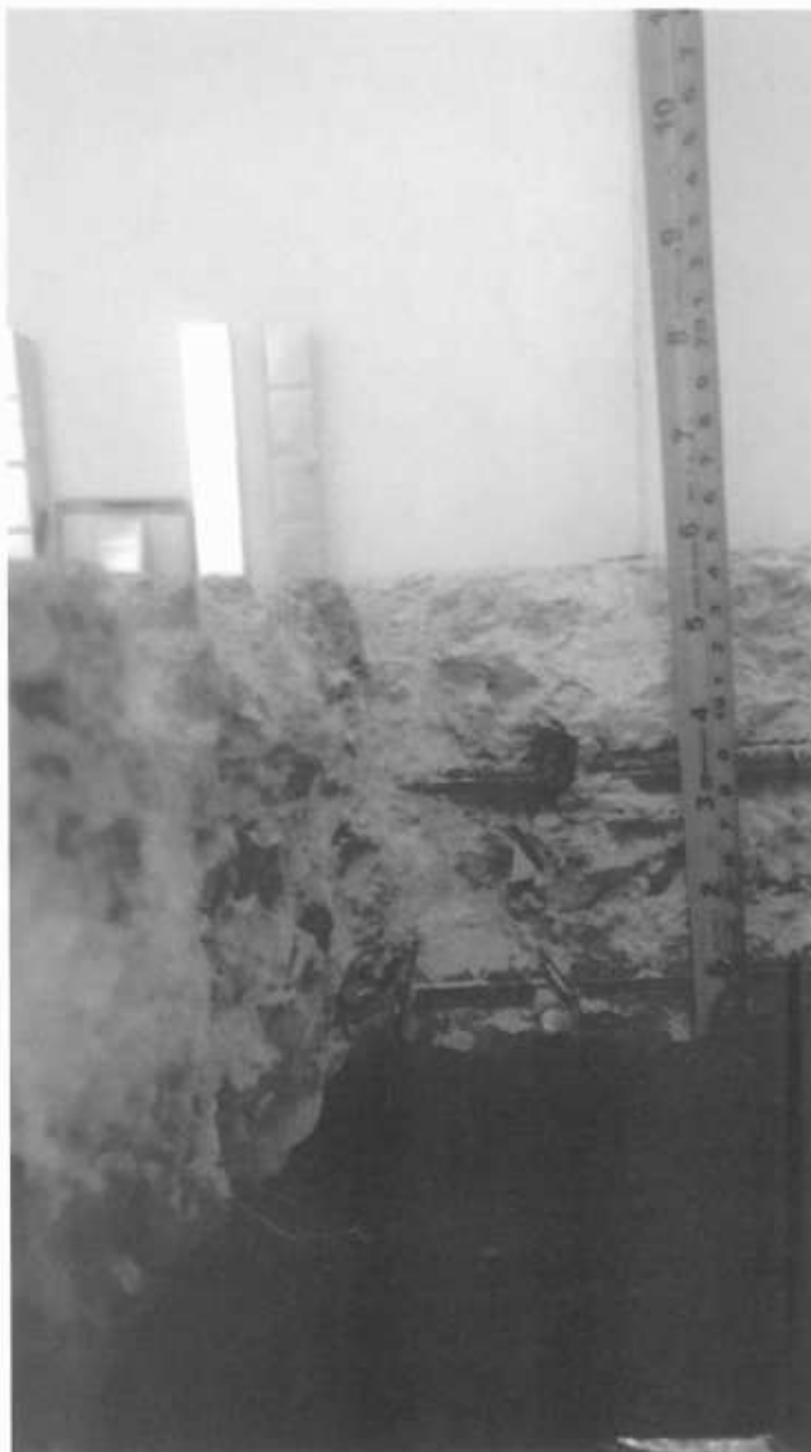
Figura 7 Se verifica el diametro de la varilla, el cual resulta de 1/2" (Varilla del #4)
