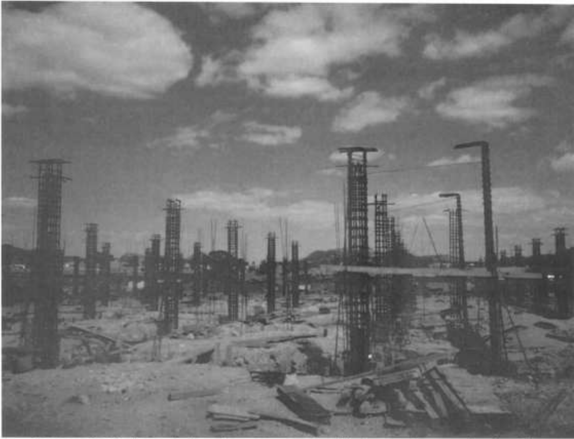
Fotografía 3. Armado de columnas, según detalle en planos estructurales
