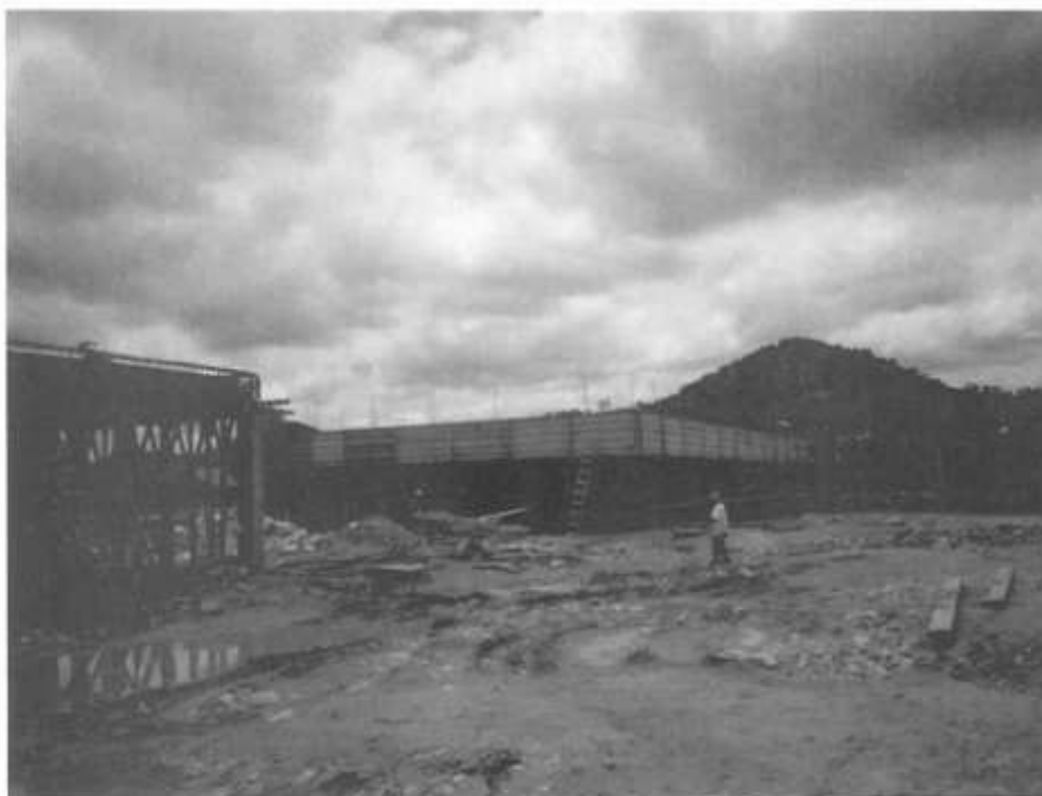
Fotografía 9. Encofrado lateral de vigas
