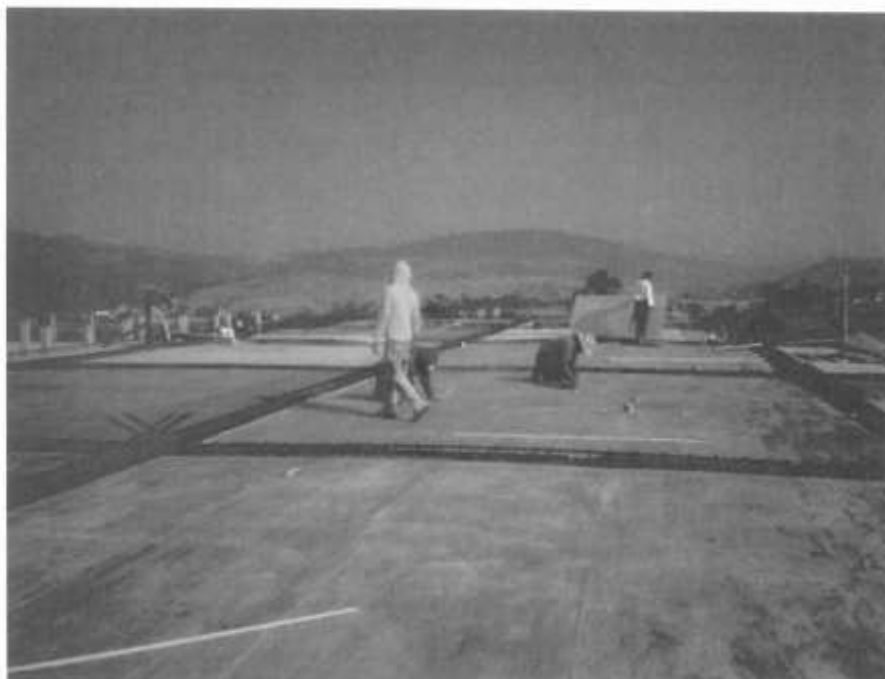
Fotografía 10. Armado de losa
