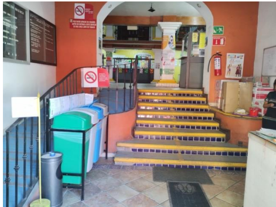
ACCESO AL INMUEBLE, SE APRECIAN MUROS
