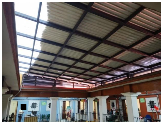
VISTA DE LA ESTRUCTURA DE LA SALA DE ESPERA
