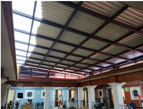
VISTA DE LA ESTRUCTURA DE LA SALA DE ESPERA
