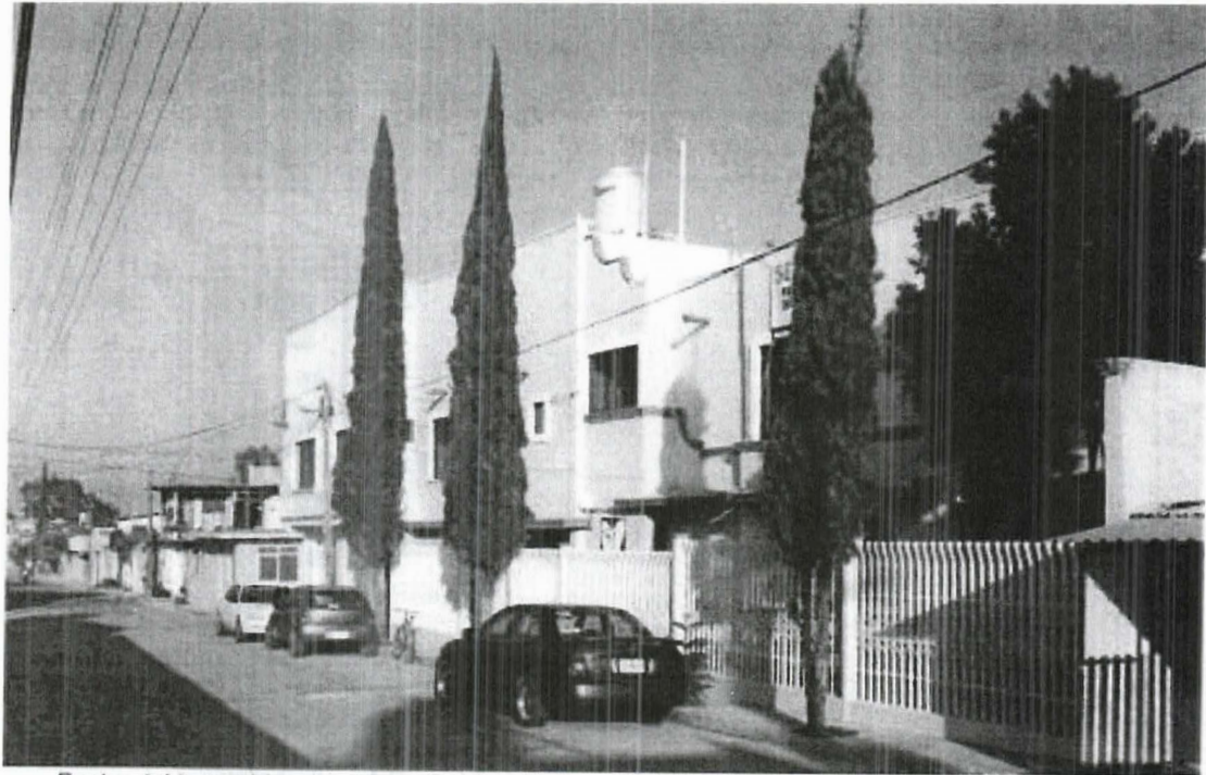
Facha del inmueble, sobre la calle Pino Suárez No. 73, Col. Sn. José, en la Villa de Etla, Oax.
