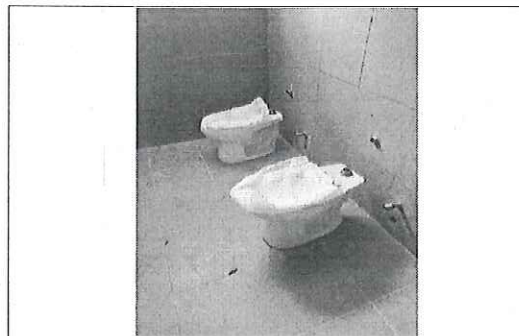
FOTO No. 5: SANITARIOS PERSONAL FOTOGRAFIA TOMADA EL DIA 15 DE ENERO DE 2026
