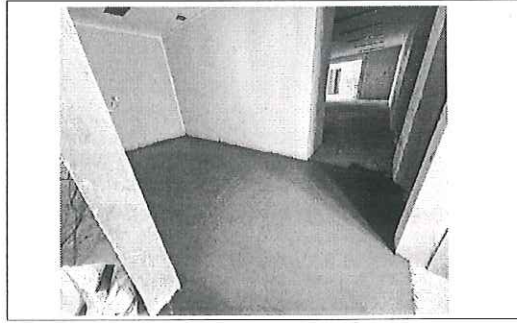
FOTO No. 2: EMPASTADOS PARA COLOCACIÓN DE PISO VINÍLICO FOTOGRAFIA TOMADA EL DIA 31 DE DICIEMBRE DE 2025
