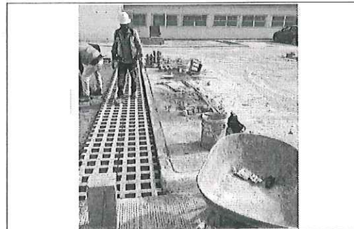
FOTO No. 8: COLOCACIÓN DE ADOPASTO EN CAJONES DE ESTACIONAMIENTO FOTOGRAFIA TOMADA EL DIA 31 DE DICIEMBRE DE 2025
