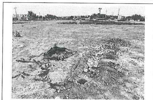
FOTO No. 4: SECCION DE TOMA DE MUESTRAS DE SONDEO MIXTO (SPT)
