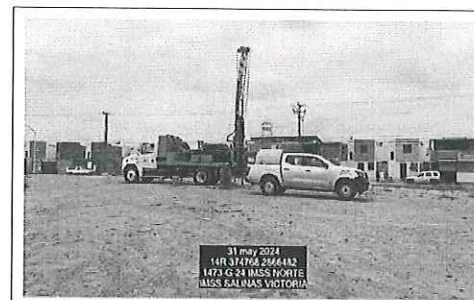
FOTO No. 3 INSTALACION DE EQUIPO
