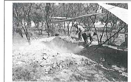
FOTO No. 3 TRABAJO DE EXCAVACION PARA CIELO ABIERTO
