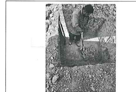
FOTO No. 6: TRABAJO DE EXCAVACION PARA LOS POZOS DE CIELO ABIERTO
