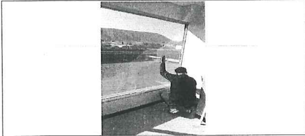
FOTO No. 1: COLOCACION DE PELICULA FILTRASOL EN HGZ 6 FOTOGRAFIA TOMADA EL DIA 2 de DICIEMBRE 2023
