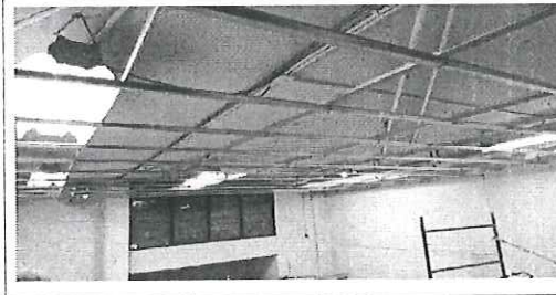
FOTO No. 2: COLOCACION DE SUSPENSION DE PLAFON DE HGZ 17 FOTOGRAFIA TOMADA EL DIA 28 DE OCTUBRE 2023
