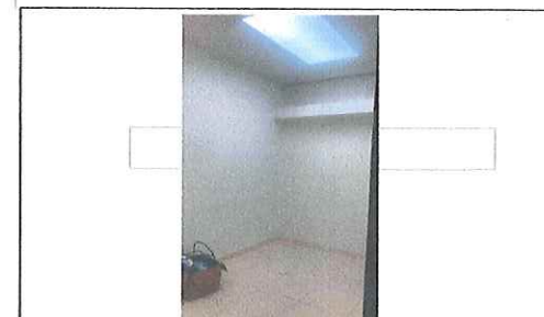
FOTO No. 9: COLOCACION DE LAMPARAS LED EN UMF 19 ESTA FOTOGRAFIA FUE TOMADA EL DIA 24 DE NOVIEMBRE 2023
