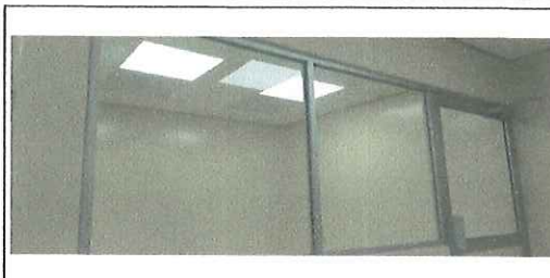
FOTO No. 2: COLOCACION DE PLAFON RETICULAR EN HGZ 33 FOTOGRAFIA TOMADA EL DIA 27 de NOVIEMBRE 2023
