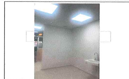
FOTO No. 6 COLOCACION DE PINTURA UMF #5 ESTA FOTOGRAFIA FUE TOMADA EL DIA 30 DE NOVIEMBRE 2023.
