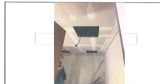
FOTO No. 3 COLOCACION DE PLAFON UMF #37 ESTA FOTOGRAFIA FUE TOMADA EL DIA 28 DE NOVIEMBRE 2023
