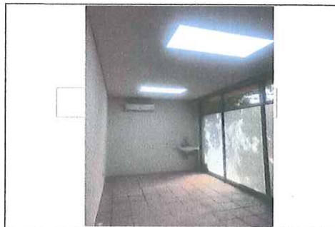
FOTO No. 5: COLOCACION DE LAVABO EN UMF #35 ESTA FOTOGRAFIA FUE TOMADA EL DIA 24 DE NOVIEMBRE 2023.
