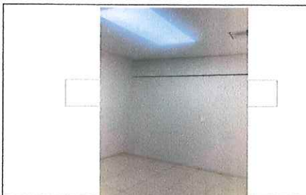
FOTO No. 8: COLOCACION DE PINTURA EN UMF 19 FOTOGRAFIA FUE TOMADA EL DIA 24 DE NOVEMBRE 2023.
