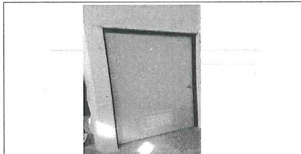
FOTO No. 4: COLOCACION DE PUERTA EN UMF #39 ESTA FOTOGRAFIA FUE TOMADA EL DIA 24 DE NOVIEMBRE 2023.
