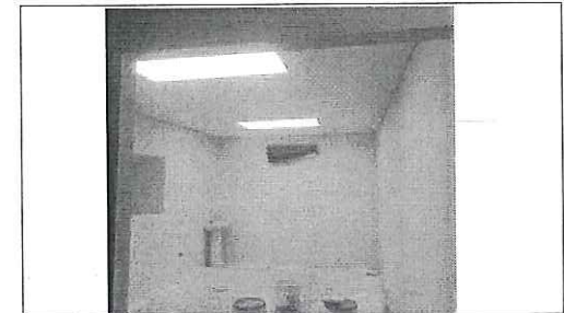
FOTO No. 9: COLOCACION DE LAMPARAS LED EN UMF 35 ESTA FOTOGRAFIA FUE TOMADA EL DIA 10 DE NOVIEMBRE 2023
