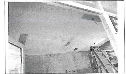
FOTO No. 6 RETIRO DE LAMPARAS EN HGZ 11 ESTA FOTOGRAFIA FUE TOMADA EL DIA 15 DE OCTUBRE 2023.
