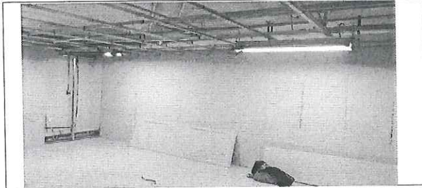
FOTO No. 1: COLOCACION DE PISO EN HGZ 17 FOTOGRAFIA TOMADA EL DIA 11 de NOVIEMBRE 2023
