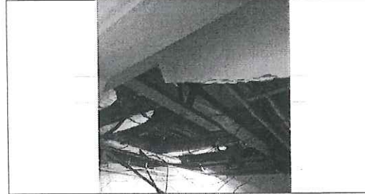
FOTO No. 2: DEMOLICION DE PLAFON EN UMF 28 FOTOGRAFIA TOMADA EL DIA 15 de NOVIEMBRE 2023
