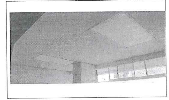
FOTO No. 6 COLOCACION DE LUMINARIAS LED UMF 30 ESTA FOTOGRAFIA FUE TOMADA EL DIA 09 DE OCTUBRE 2023.
