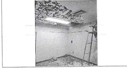
FOTO No. 2: DEMOLICION DE PLAFON UMF 7 FOTOGRAFIA TOMADA EL DIA 09 DE OCTUBRE 2023
