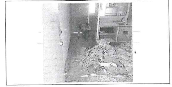
FOTO No. 3 RETIRO DE PISO VINILICO UMF 5 FOTOGRAFIA TOMADA EL DIA 12 DE OCTUBRE 2023
