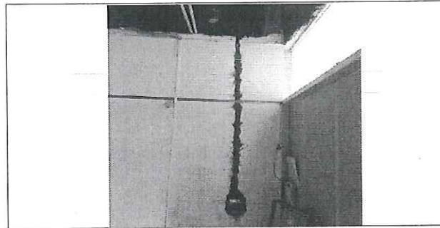
FOTO No. 4: RANURA Y RESANE PARA INSTALACIONES UMF 5 ESTA FOTOGRAFIA FUE TOMADA EL DIA 13 DE OCTUBRE 2023.
